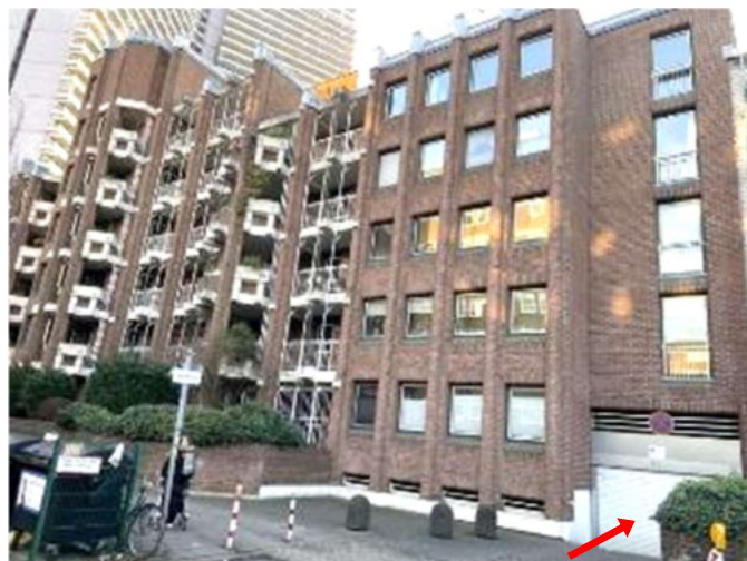
Wohn- und Bürogebäude Universitätsstraße 5, 7 mit TG-Einfahrt
