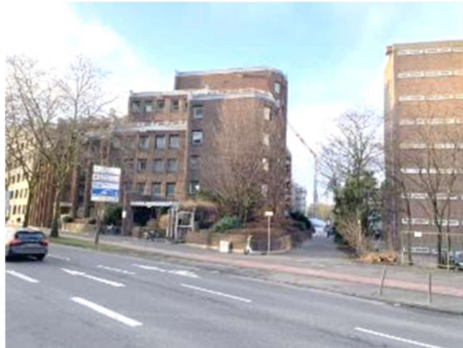
Wohn- und Bürogebäude Universitätsstraße 5, 7 mit Fußweg
