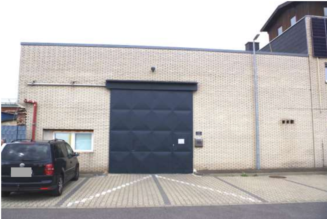
Bild 5: Ansicht der Lagerhalle / Gebäude 10
