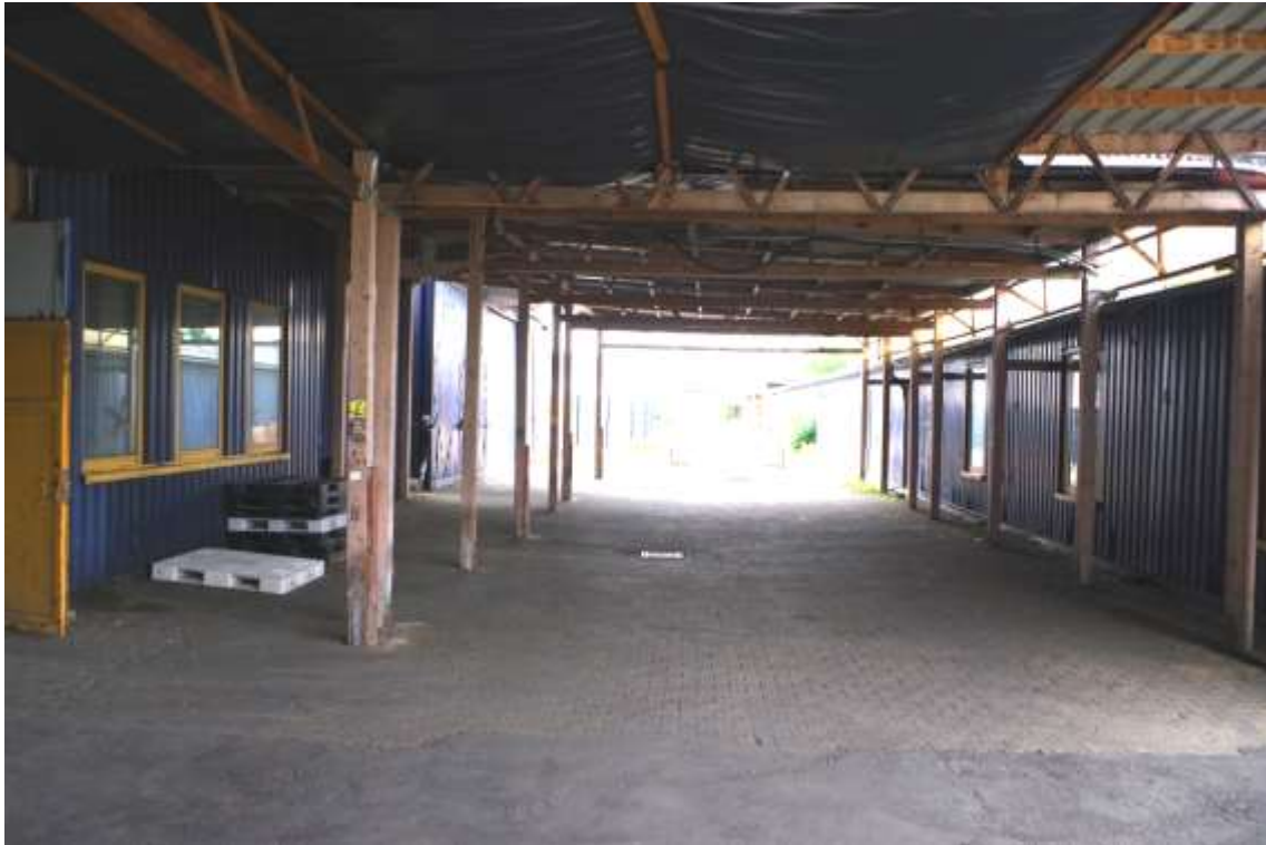
Bild 7: Ansicht der Lagerhalle / Büro (Gebäude 6, 8)
