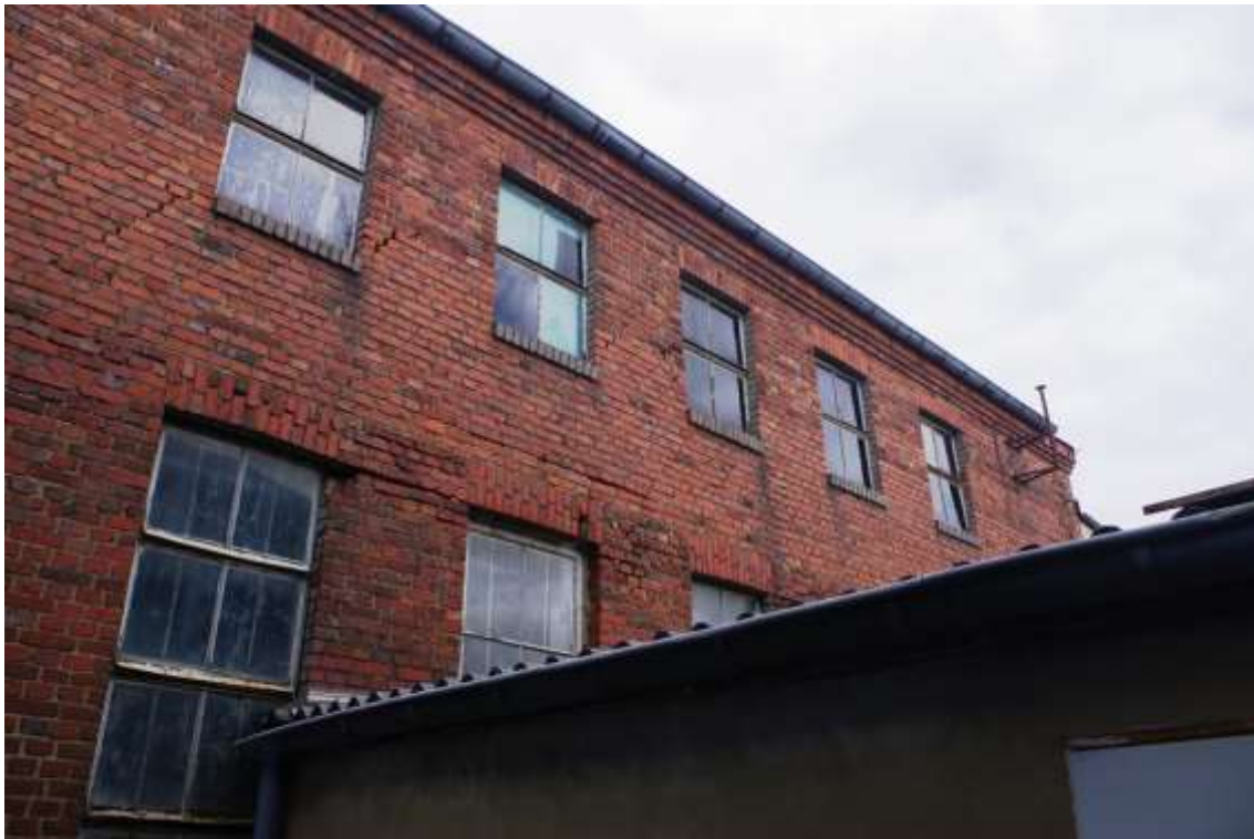
Bild 11: Ansicht der Lagerhalle / Gebäude 5
