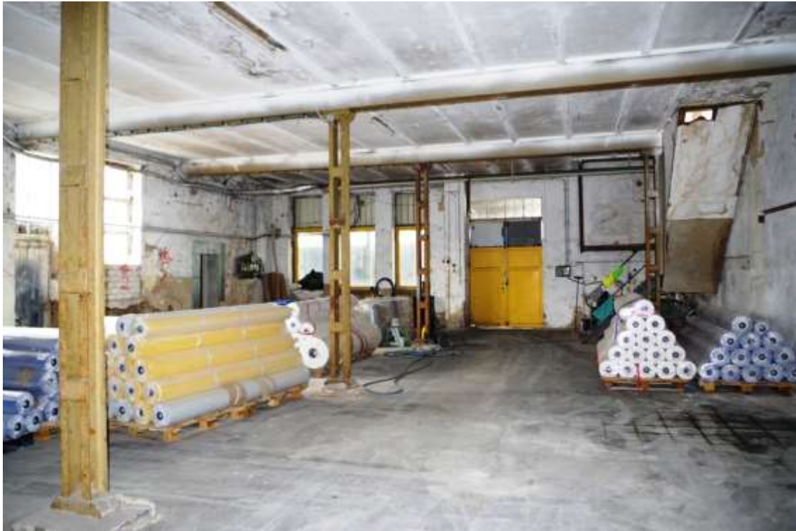
Bild 21: Ansicht Lagerhalle / Gebäude 5 (Erdgeschoss)
