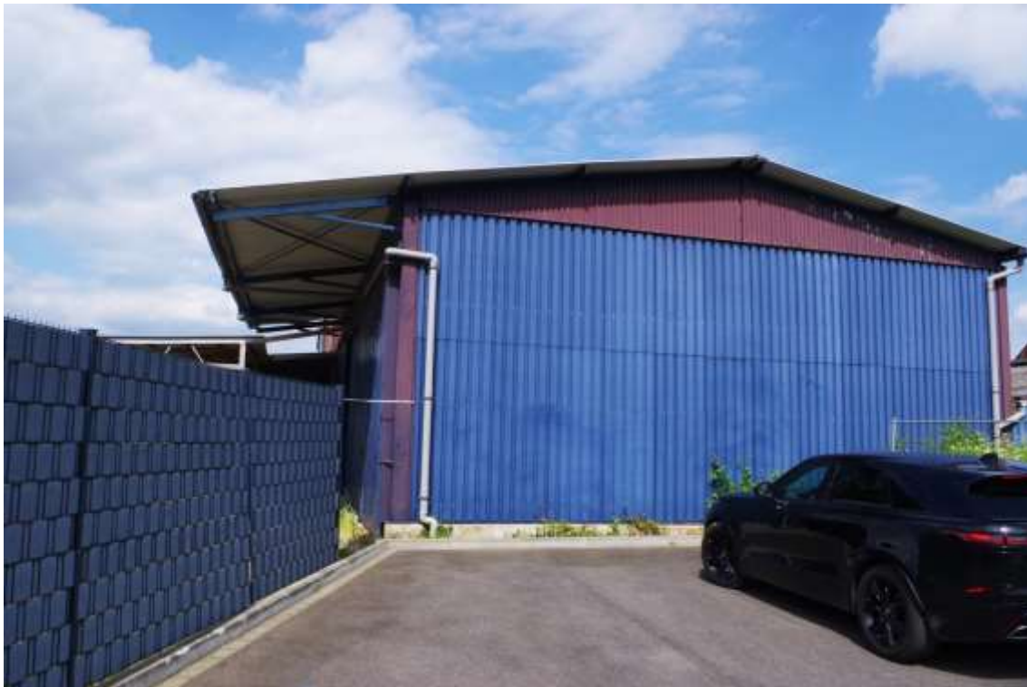
Bild 2: Ansicht Lagerhalle / Gebäude 6
