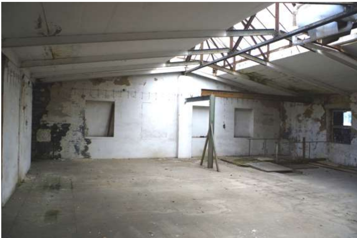
Bild 24: Ansicht Lagerhalle / Gebäude 5 (Obergeschoss)
