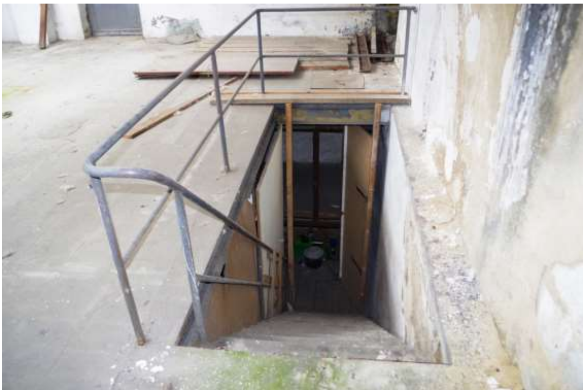
Bild 28: wie vor, Ansicht der Treppe
