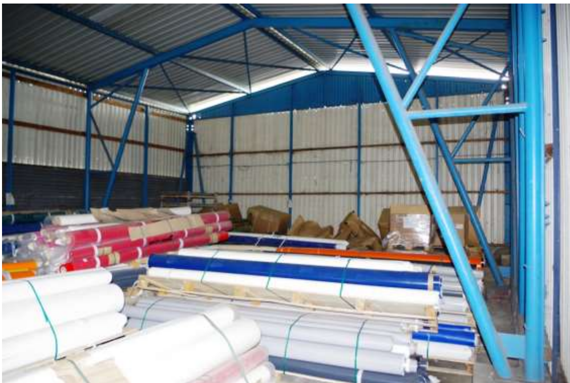
Bild 31: Ansicht der Lagerhalle / Gebäude 6
