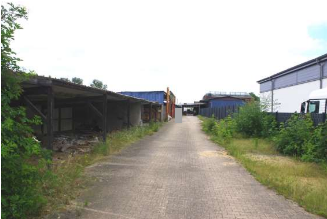
Bild 14: Ansicht der Zuwegung (über Zufahrt „Schwarzer Weg“)
