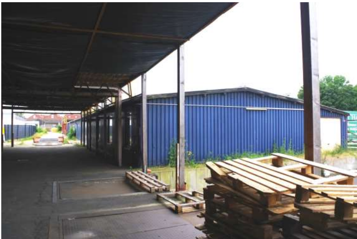
Bild 8: Ansicht des Lager,- Bürogebäudes 8 aus Nord
