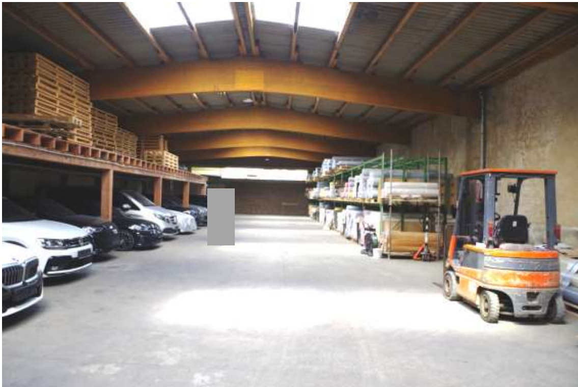
Bild 19: Innenansicht Lagerhalle / Gebäude 10
