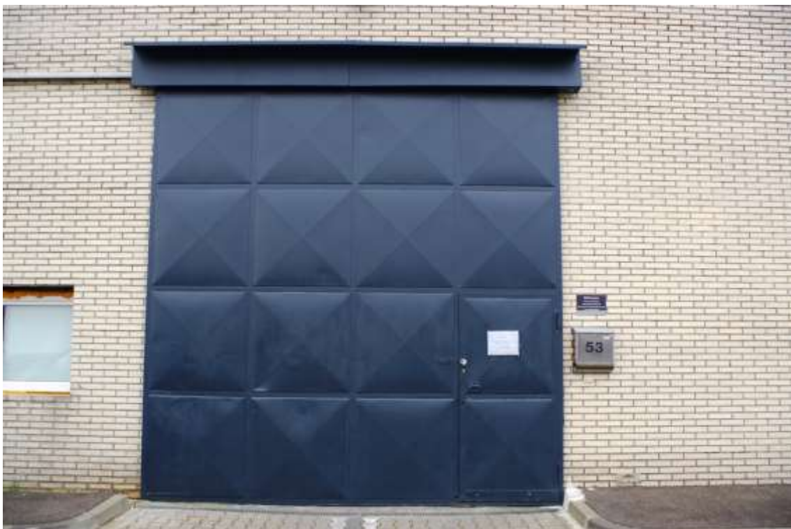
Bild 6: wie vor, Detailansicht Zufahrtstor
