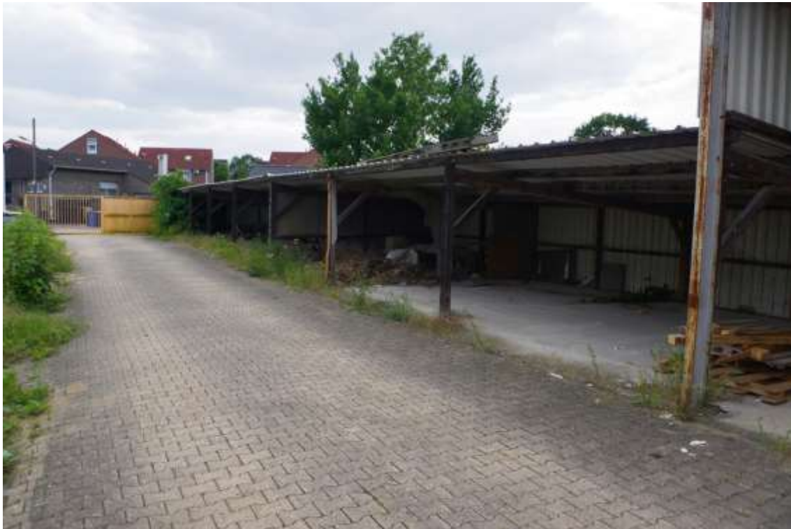
Bild 13: Ansicht des Unterstands / Gebäude 9
