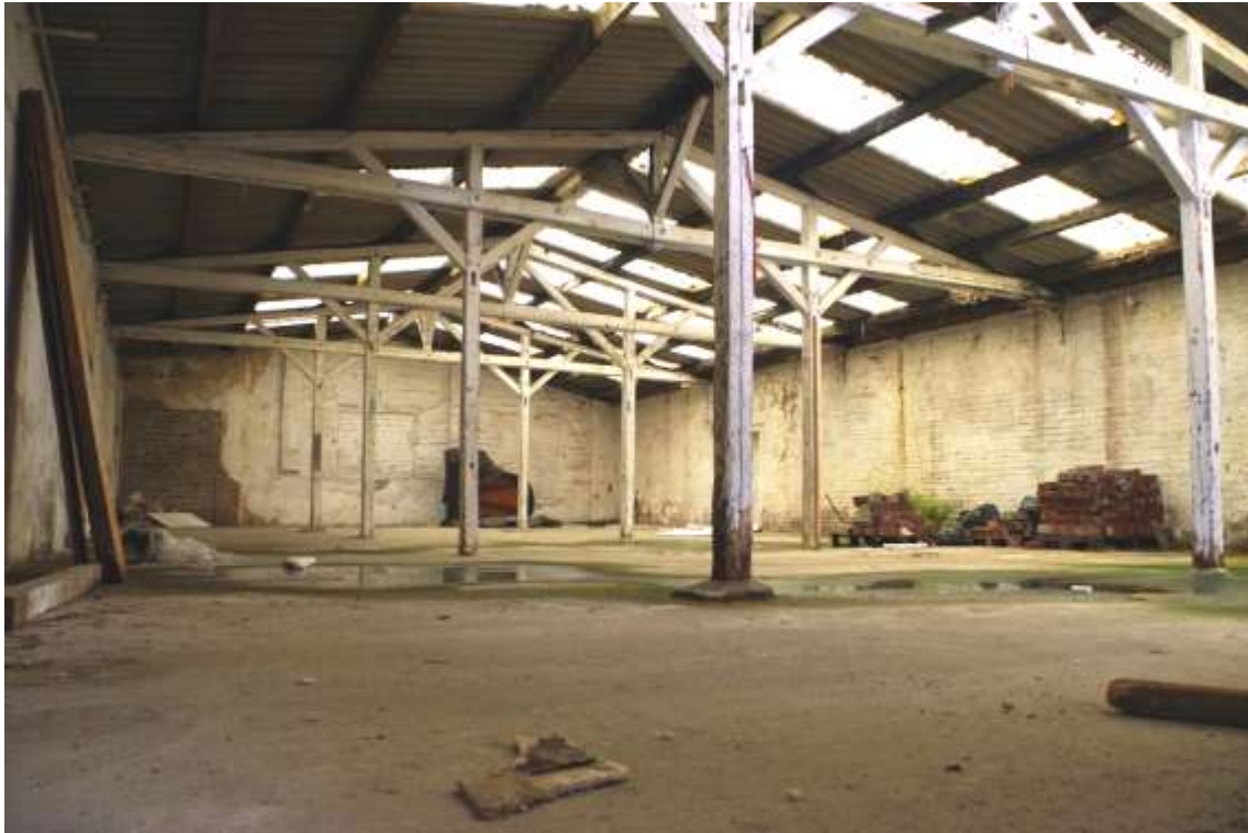
Bild 34: Innenansicht Lagerhalle / Gebäude 3
