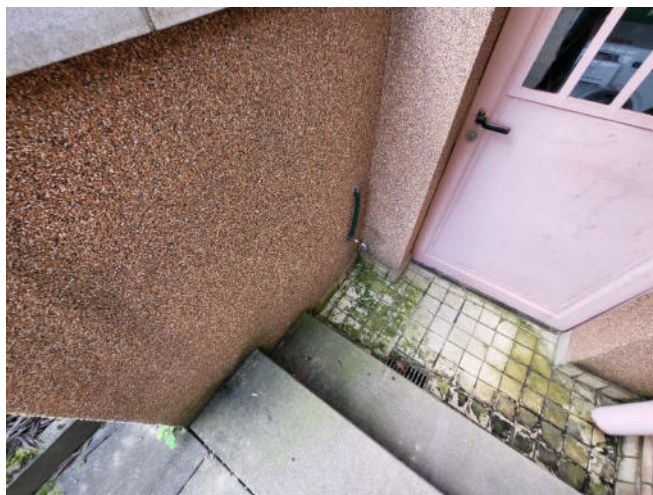
Kellertreppe zum Waschkeller (Gartenseite)
