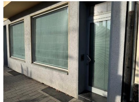
separater Hauseingang der Gewerbefläche G2 an der Neusser Straße
