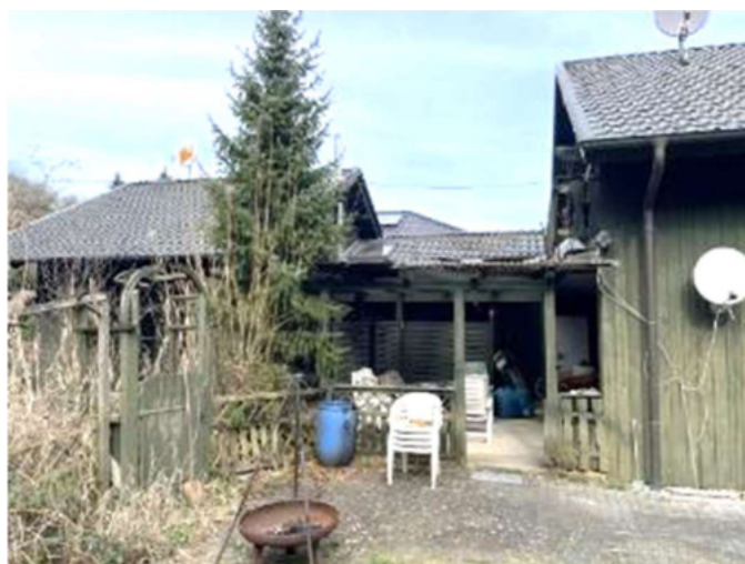
Südansicht Zwischenbau und Anbau
