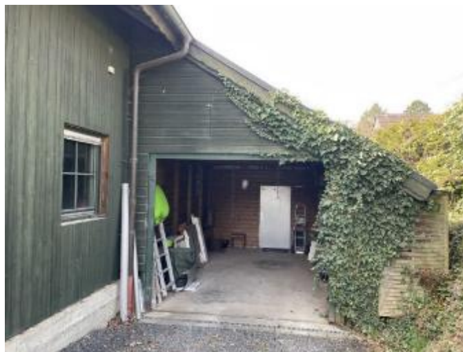
Eingang zum Zwischenbau und Anbau mit Eingang
