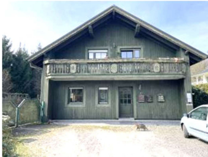
Ostansicht mit Eingang Haupthaus
