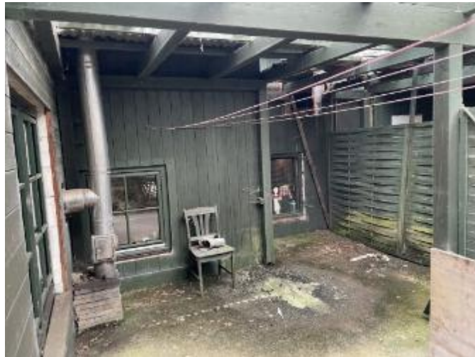
Überdachte Terrasse zwischen Haupthaus und Anbau
