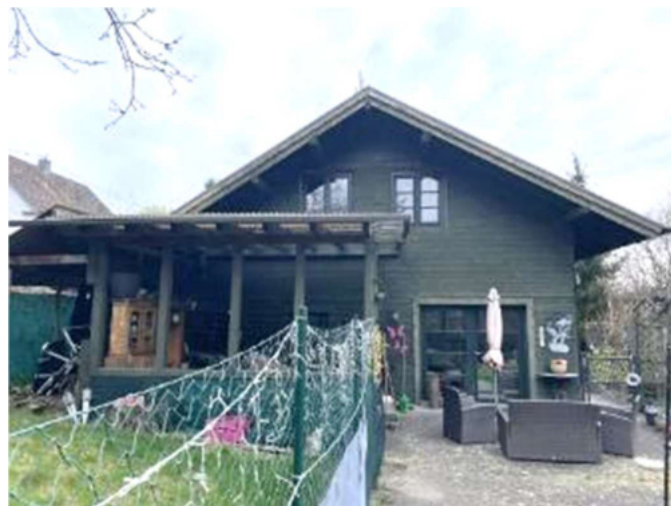
Westansicht mit überdachter Terrasse
