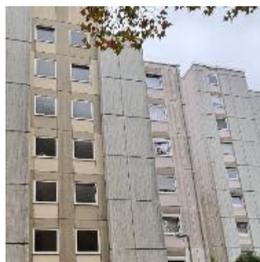
Vorgehängte Betonfassade (2)
