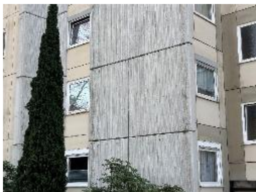
Vorgehängte Betonfassade (1)
