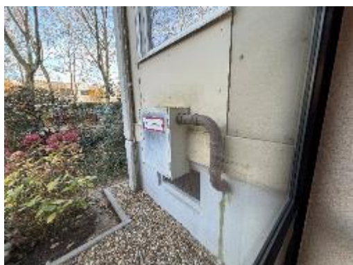
Vorgehängte Tresaplatten (1)
