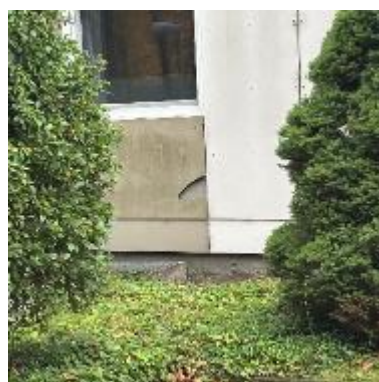
Vorgehängte Tresaplatten (2)
