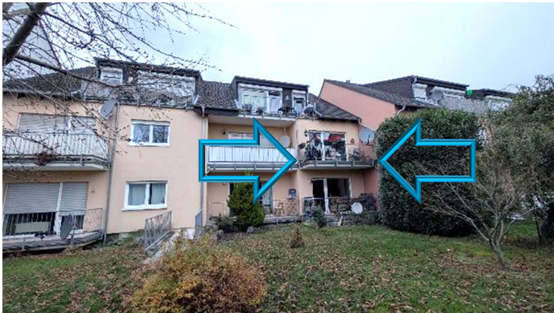
Bild B3 Gebäuderückseite
