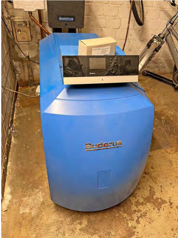
Öl-Zentralheizung, Brennwertkessel
