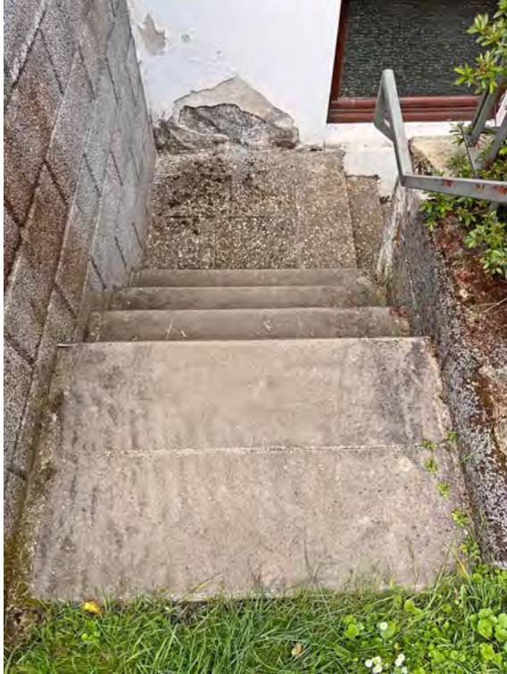
Kelleraußentreppe, Feuchtigkeitsschaden
