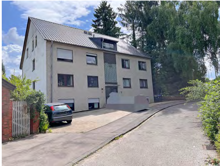
Haus-Heyden-Straße 52, Ansicht von Nordwesten
