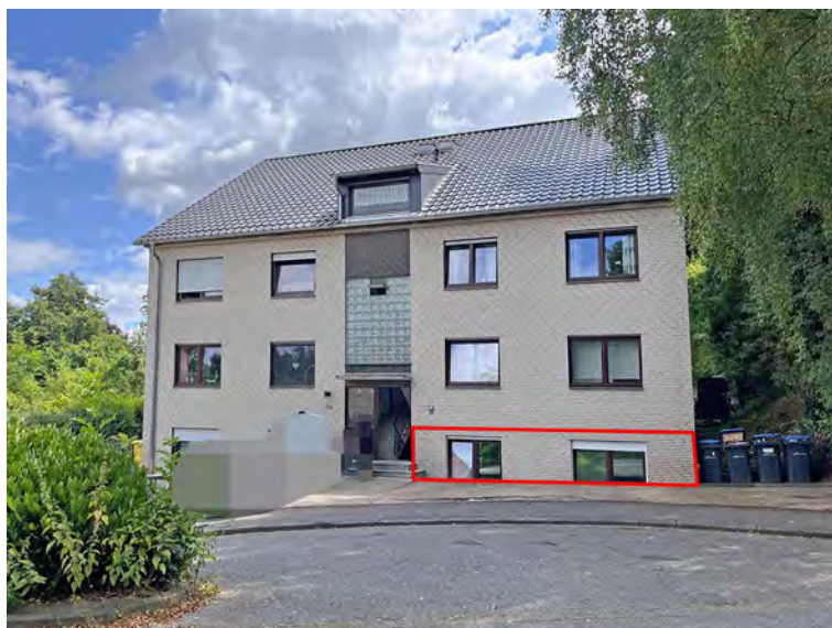
Ansicht von Westen mit ATP-Nr. 8 im Kellergeschoss rechts
