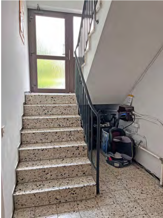
Treppe ins Kellergeschoss
