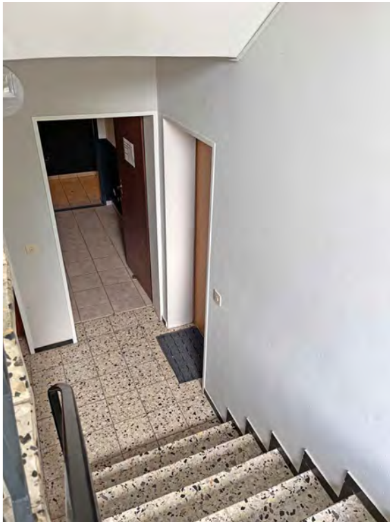
Zugang zum Kellergeschoss mit ATP-Nr. 8 rechts
