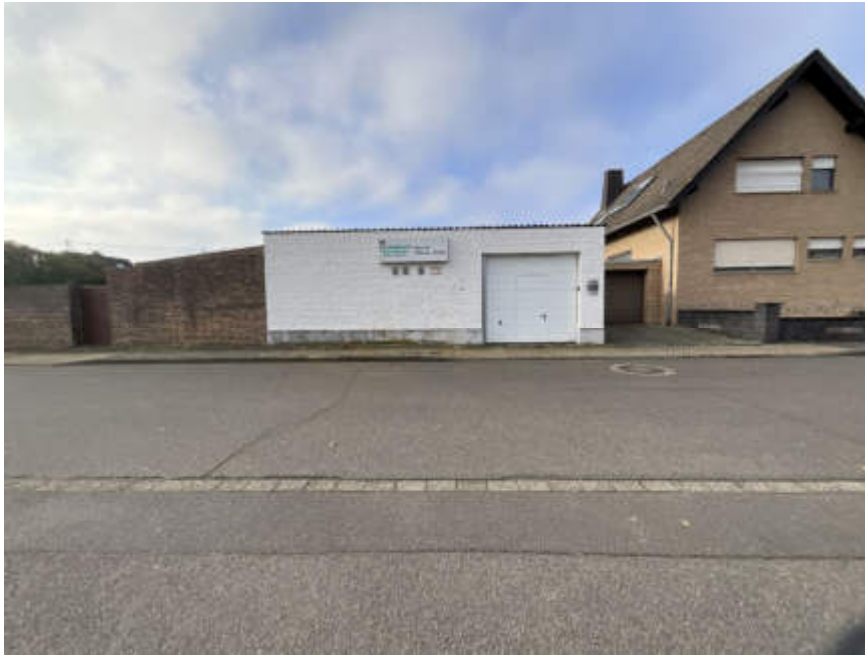
7) Ostansicht Garagengebäude / Franz-Lehnen-Straße
