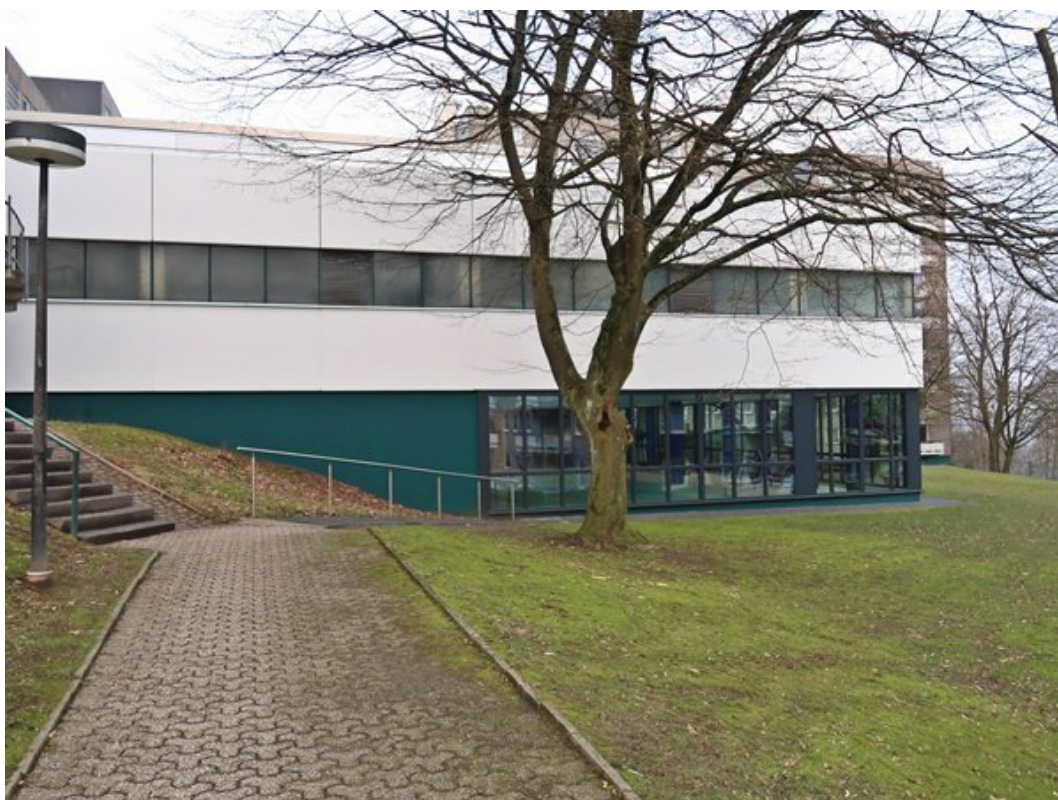
Seitenansicht, im 1. Obergeschoss das Parkdeck
