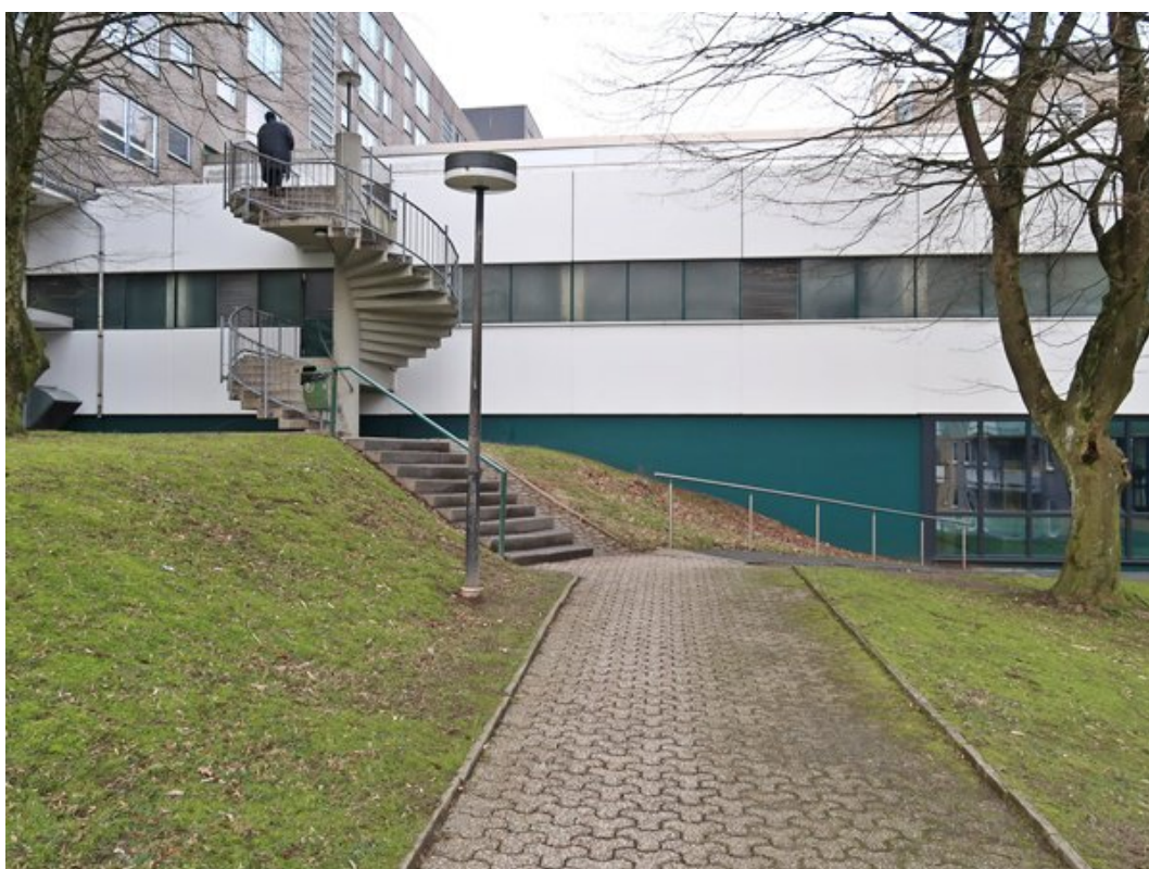
Zugang Parkdeck über Wendeltreppe
