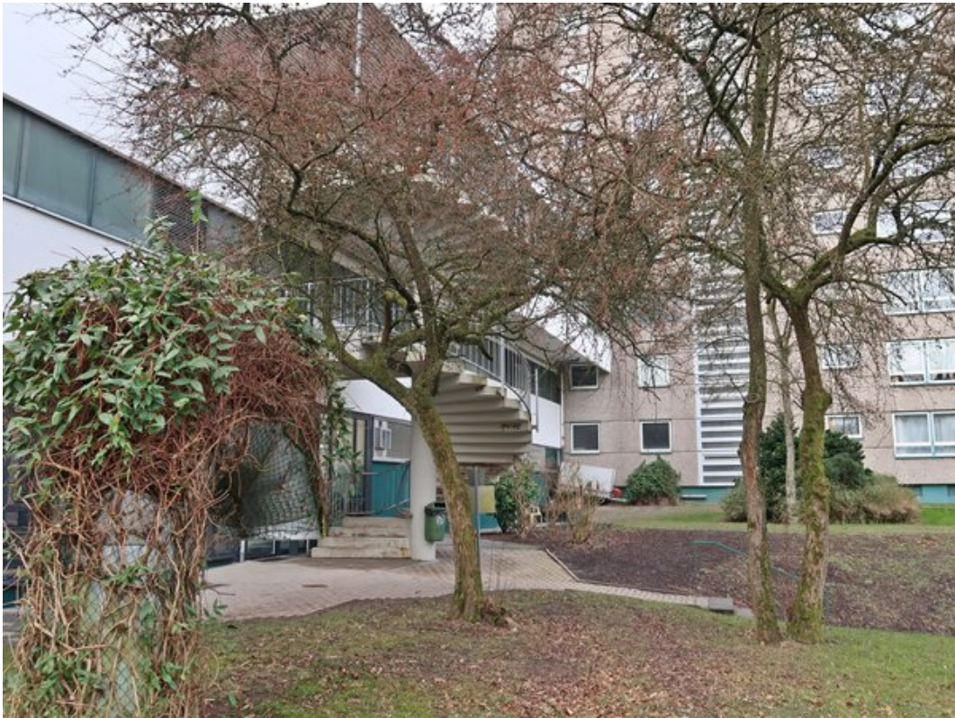
Weiterer Zugang Parkdeck über Wendeltreppe
