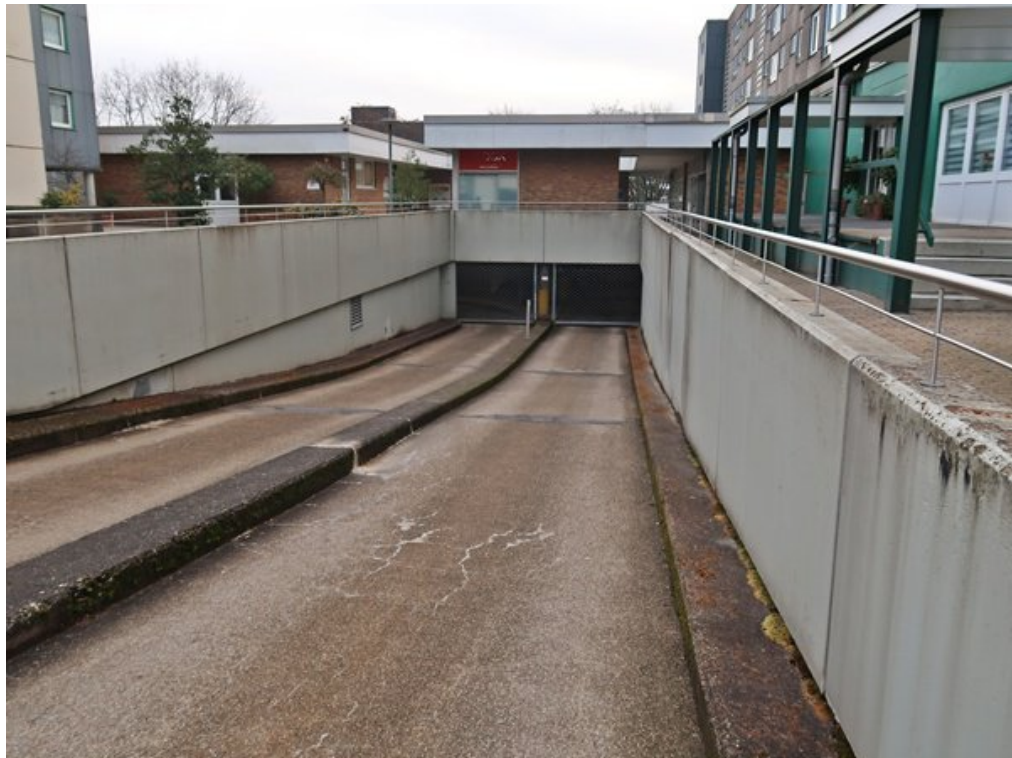
Zufahrt Parkdeck von der Straße Im Johannistal
