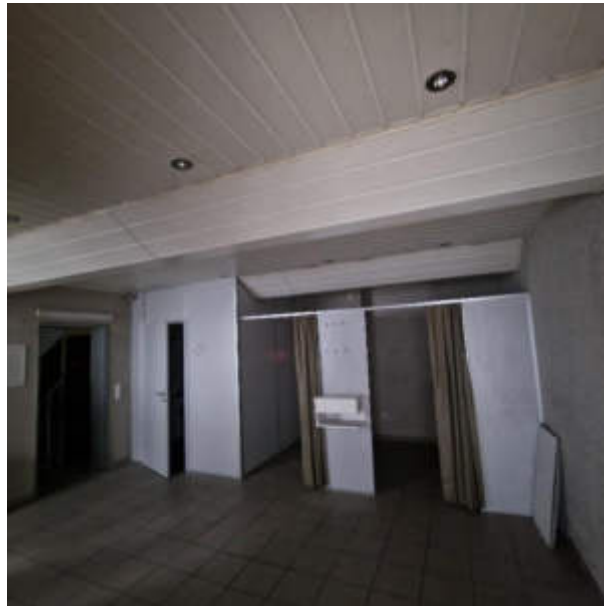
Raum Erdgeschoss Nebengebäude
