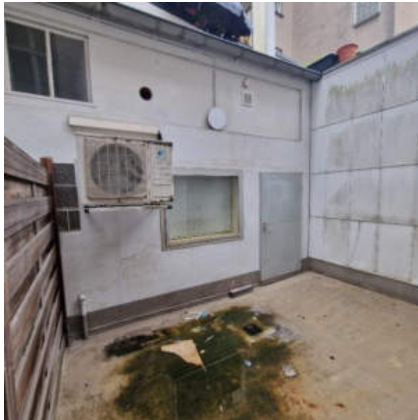
Rückansicht 2, Erdgeschoss Wohn- und Geschäftshaus
