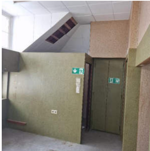
Raum 2. Obergeschoss/Dachgeschoss Nebengebäude
