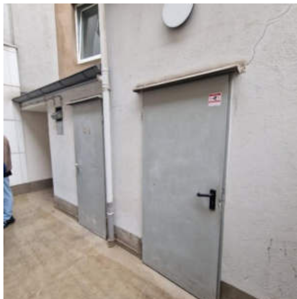
Rückansicht 1, Erdgeschoss Wohn- und Geschäftshaus
