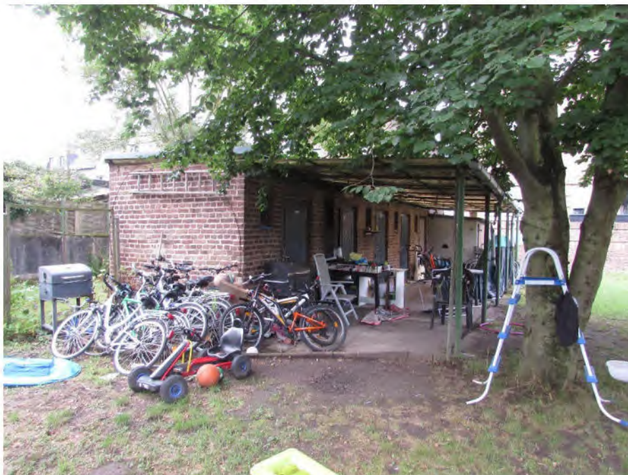
Foto 16: Nebengebäude, Schuppen, Front-/Rückansicht
