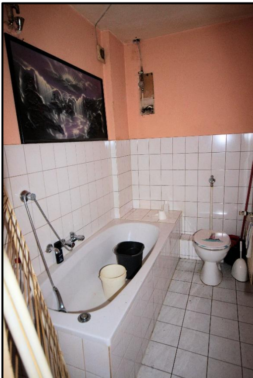
Bild 48: Bad der Wohneinheit Nr. 4 im Dachgeschoss
