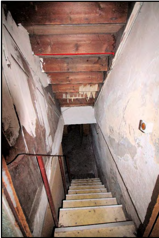
Bild 23: Treppe zum Kellergeschoss
