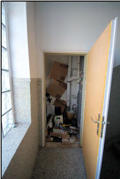
Bild 18: ehemaliger WC-Raum auf halber Treppe im Treppenhaus
