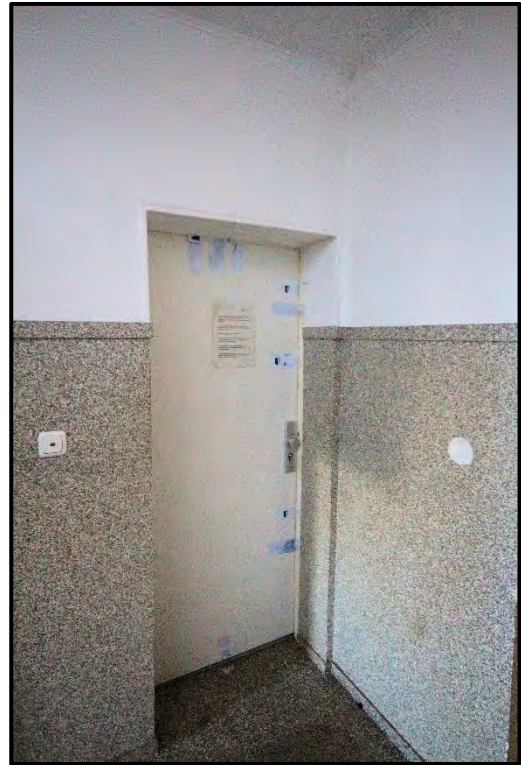
Bild 17: Wohnungstür der Wohneinheit Nr. 1 im Erdgeschoss
