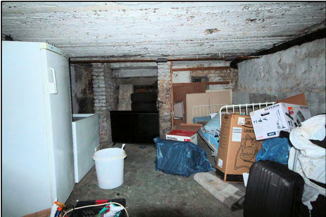
Bild 28: Kellerraum einer Wohneinheit
