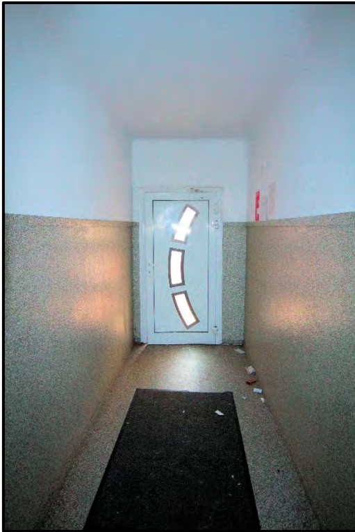
Bild 13: Treppenhaus im Eingangsbereich
