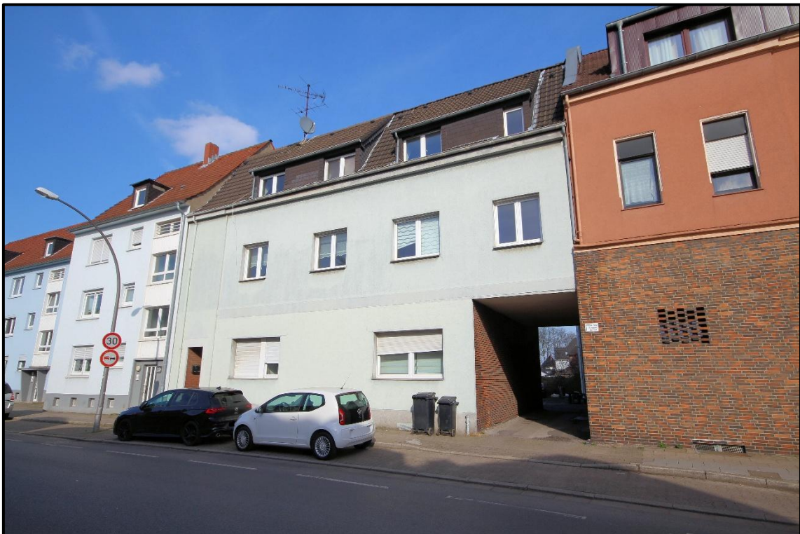
Bild 4: Ansicht von Südwesten
