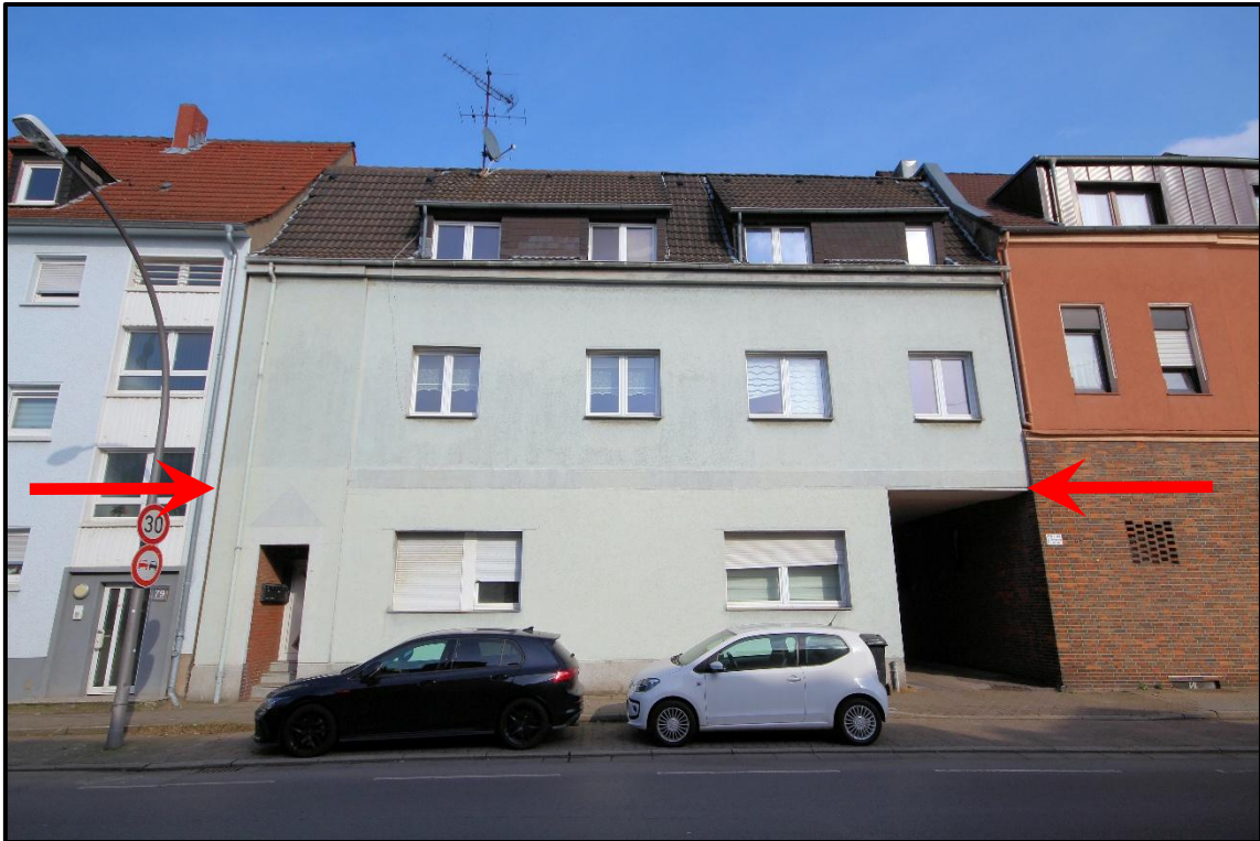
Bild 3: Ansicht von Westen
