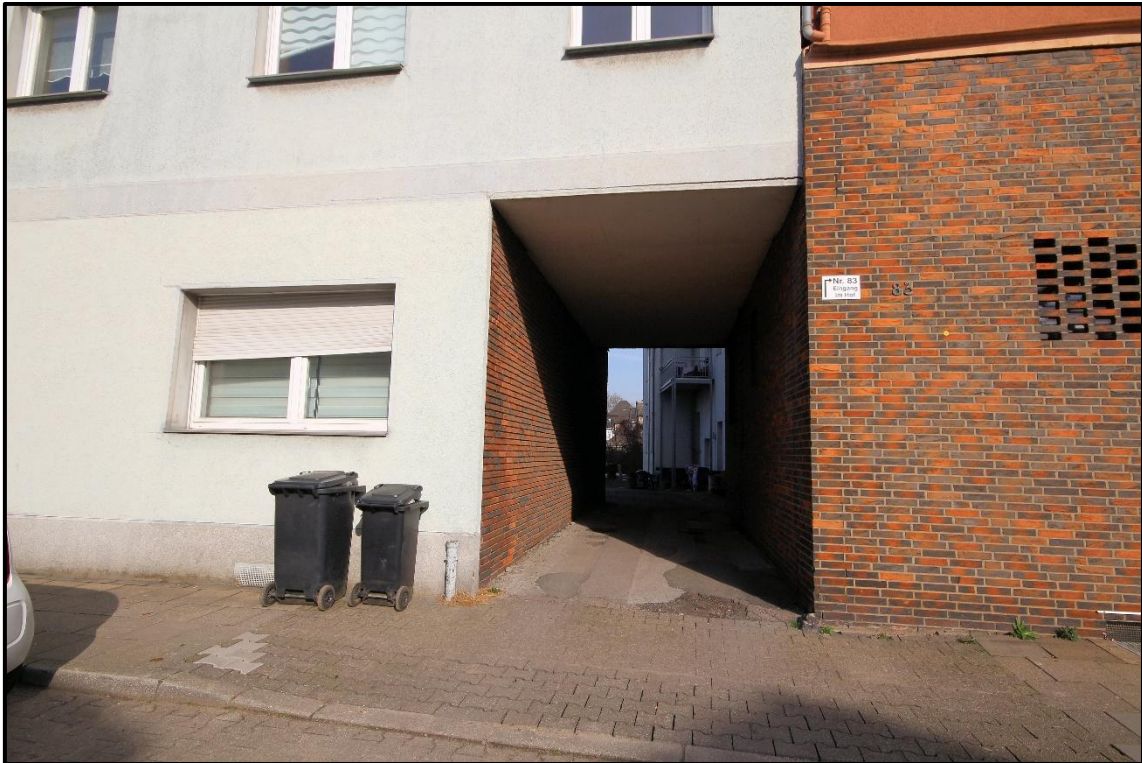
Bild 7: Durchfahrt zum Innenhof
