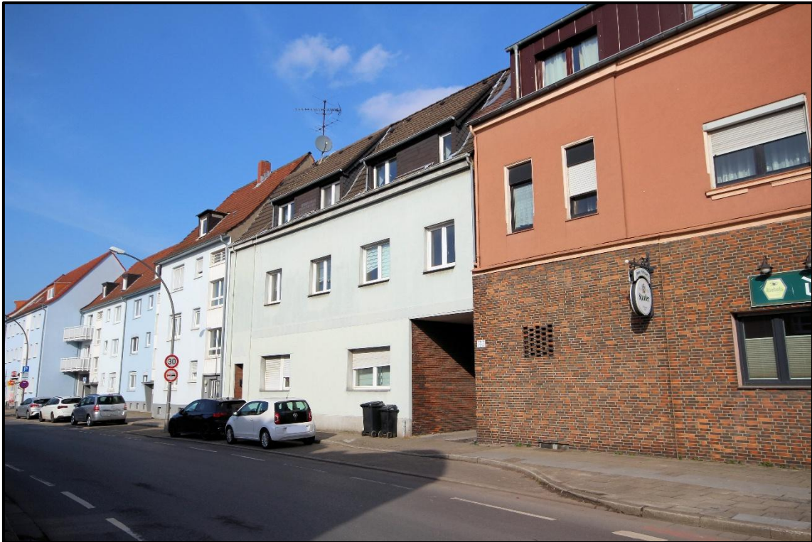
Bild 5: Ansicht von Süden
