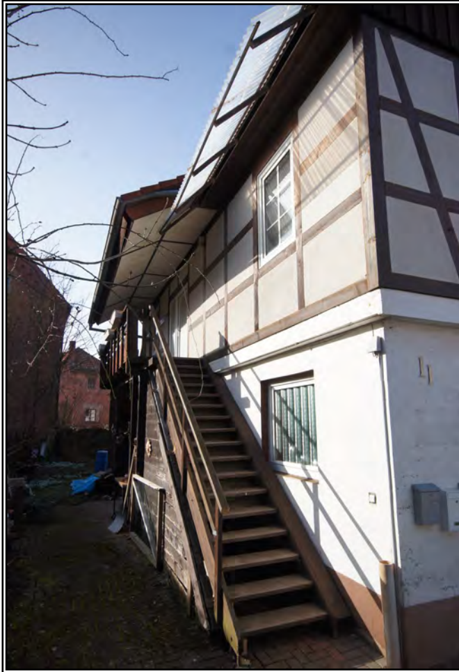
Seitenansicht von Südosten
