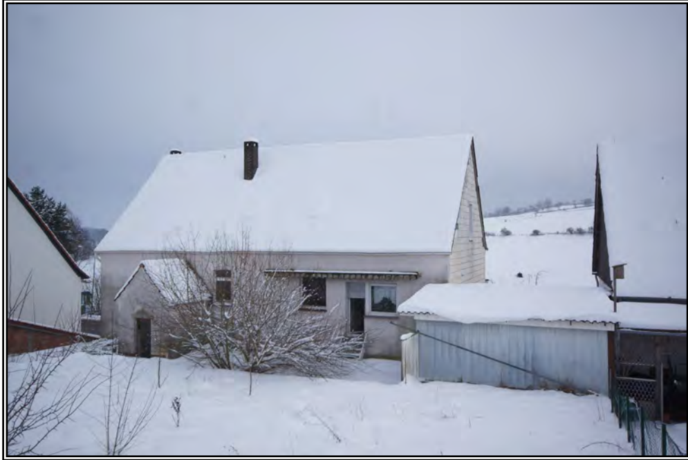
Rückwärtige Ansicht von Westen
