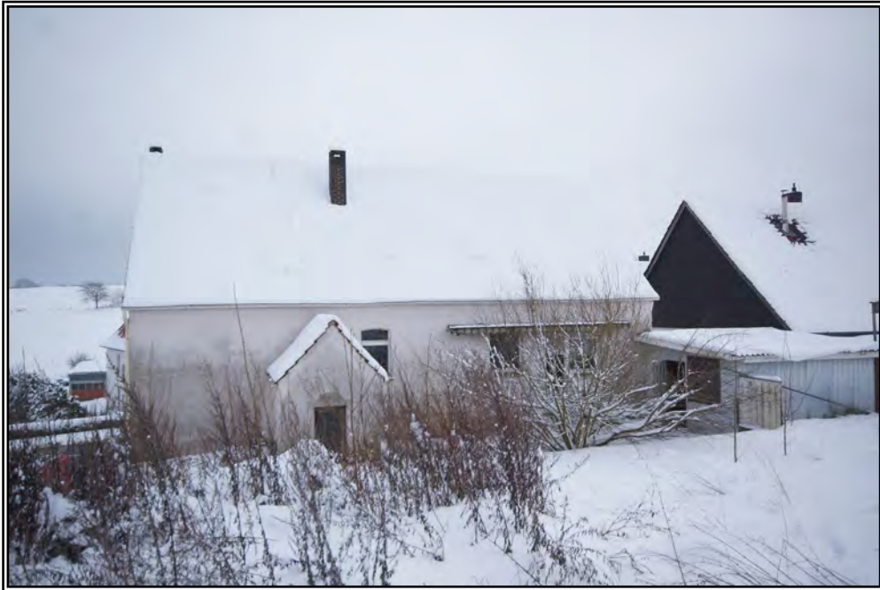
Rückwärtige Ansicht von Nordwesten
