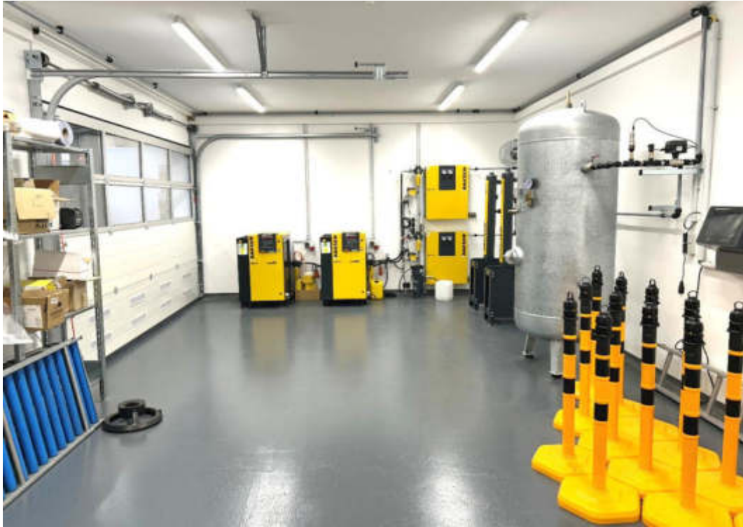
Halle 2: Nebenraum im Erdgeschoss
