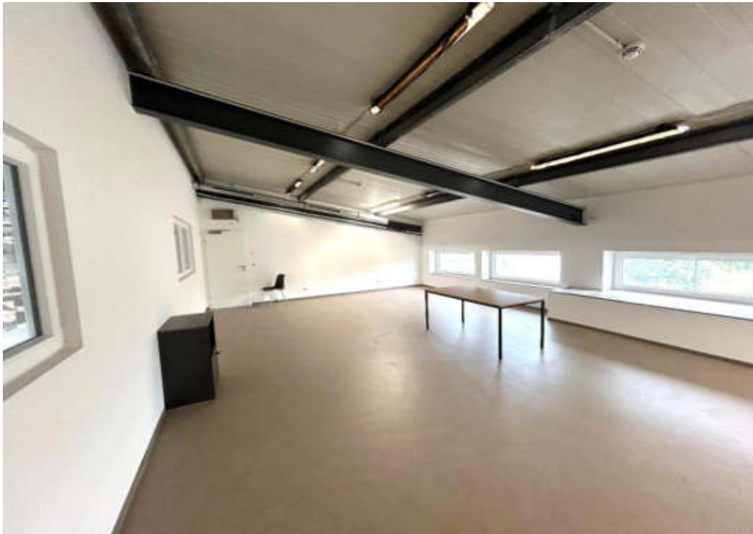
Halle 2: Aufenthaltsraum im Obergeschoss
