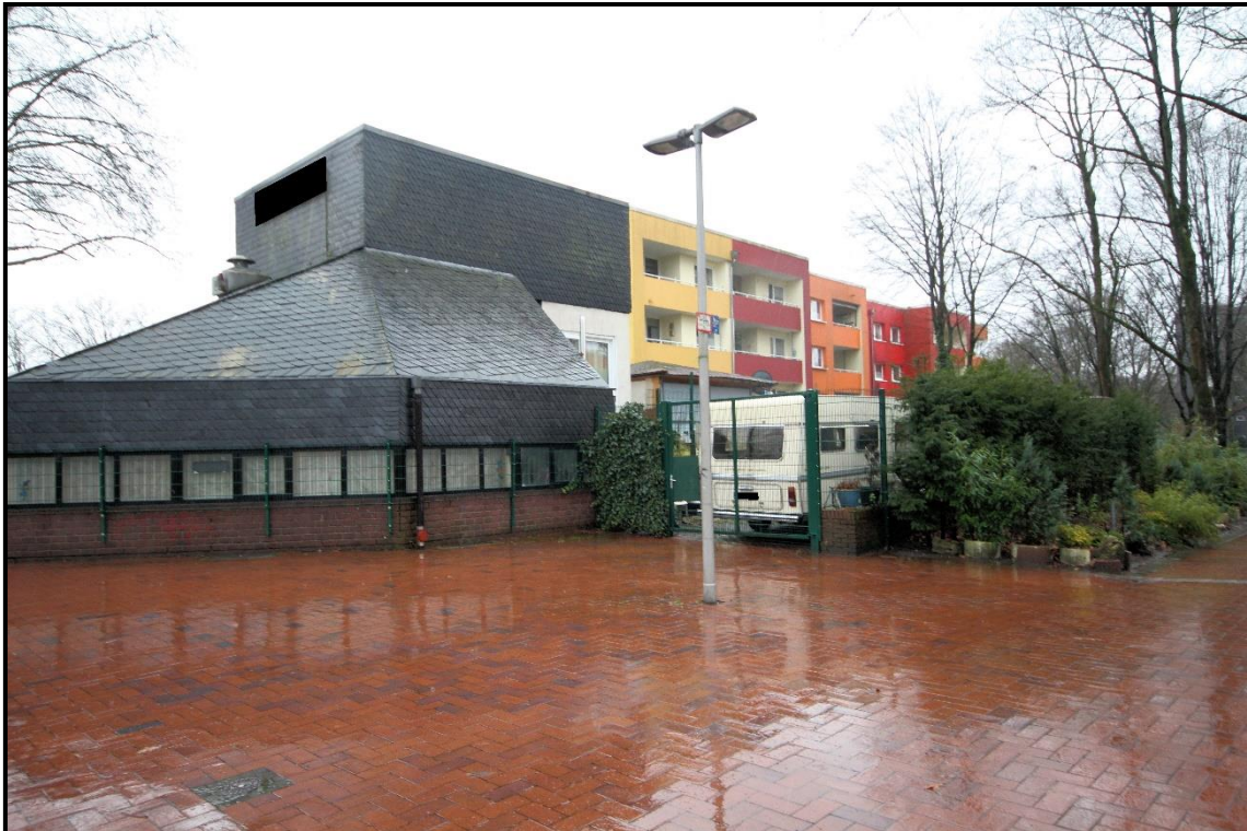
Bild 5: Ansicht von Nordwesten
