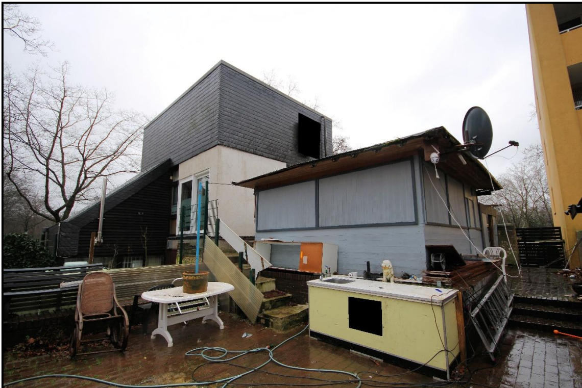
Bild 10: Ansicht von Südwesten
