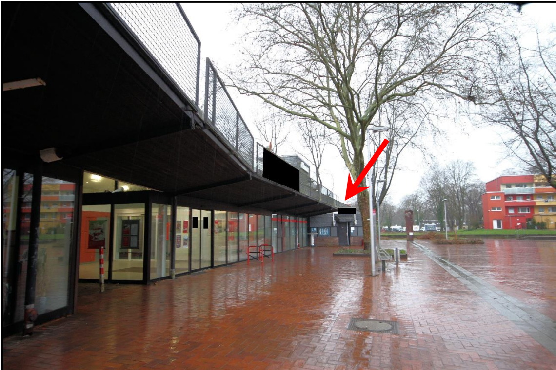
Bild 1: Blick in den östlichen Bereich der Ladenzeile nach Westen
