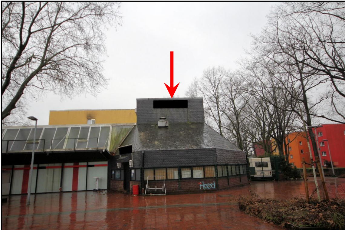
Bild 3: Ansicht von Norden
