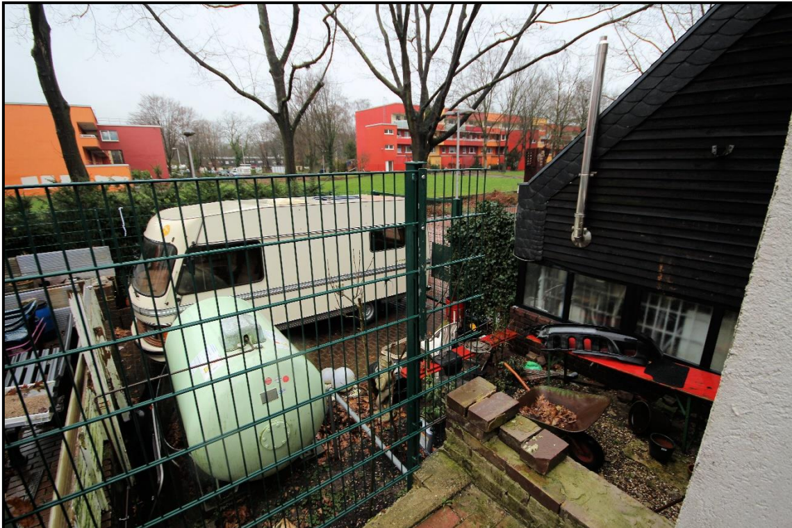
Bild 7: Flüssiggastank der Teileinheit im Außenbereich
