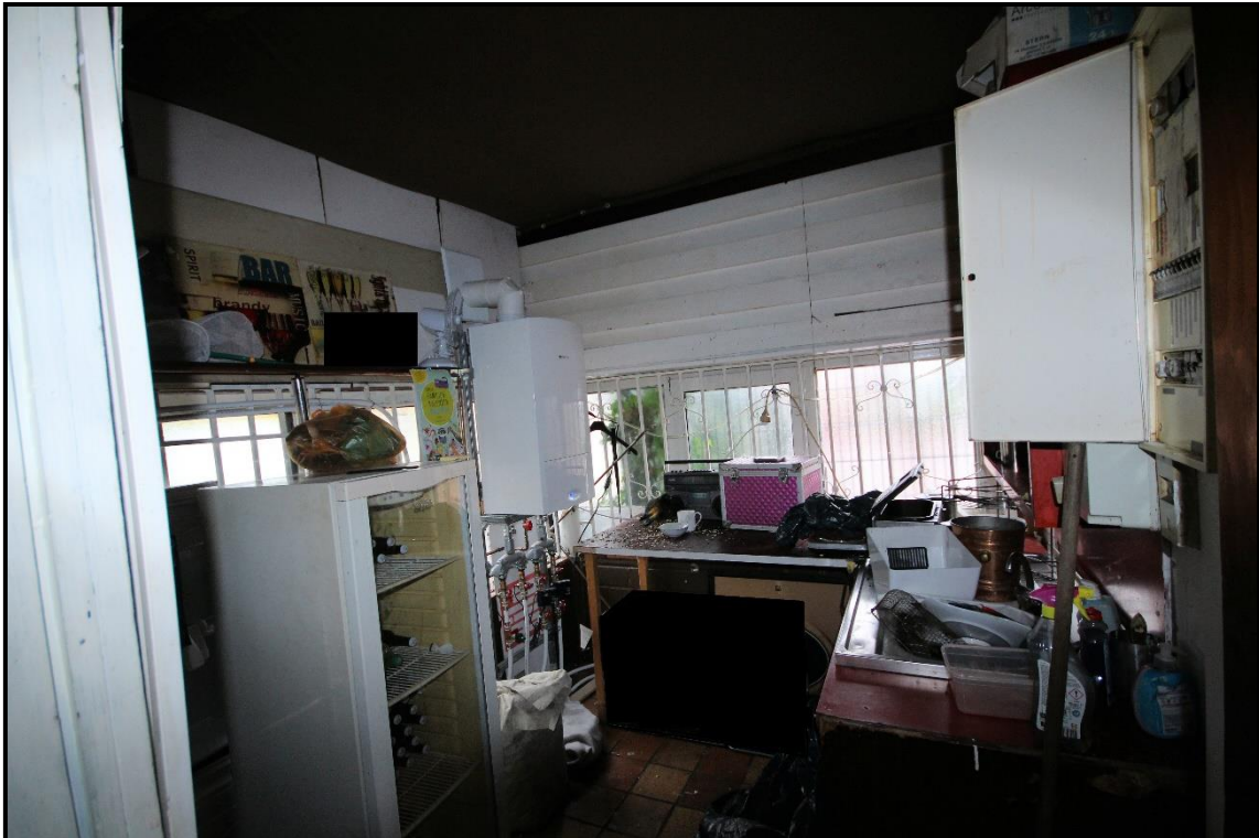
Bild 19: Heizungsraum und Getränkelager
