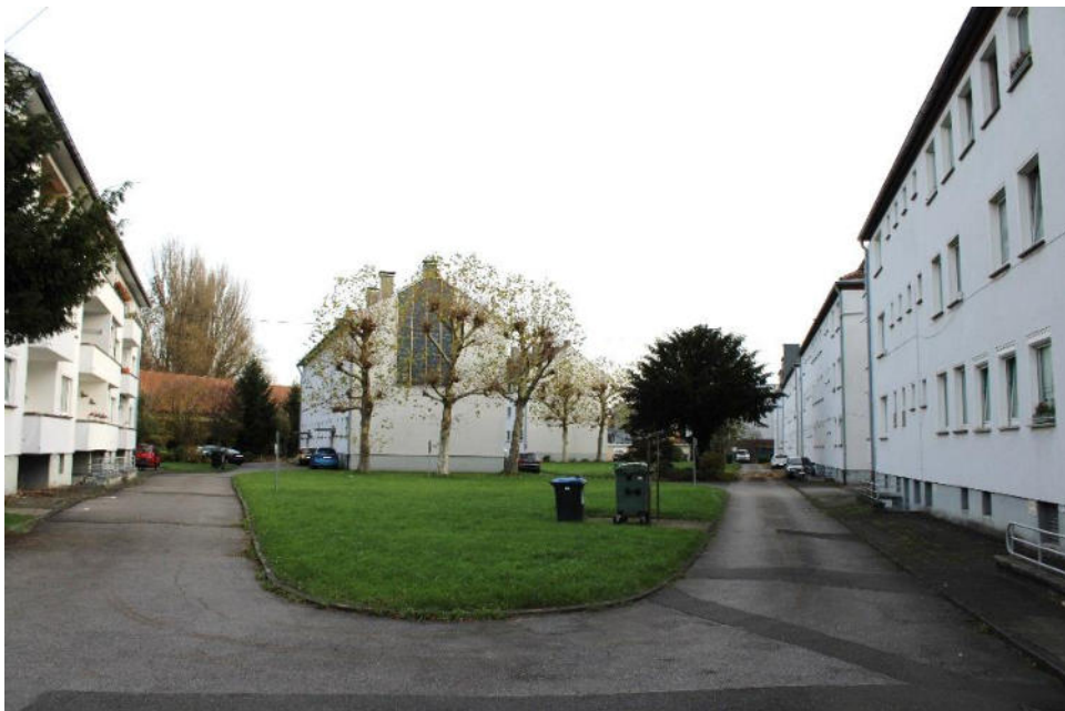
Bild 6: rückseitige Grundstückfläche / Nordwestansicht der Häuserzeile 166 - 156 / Südwestgiebel 166a / Südostansicht 168a
