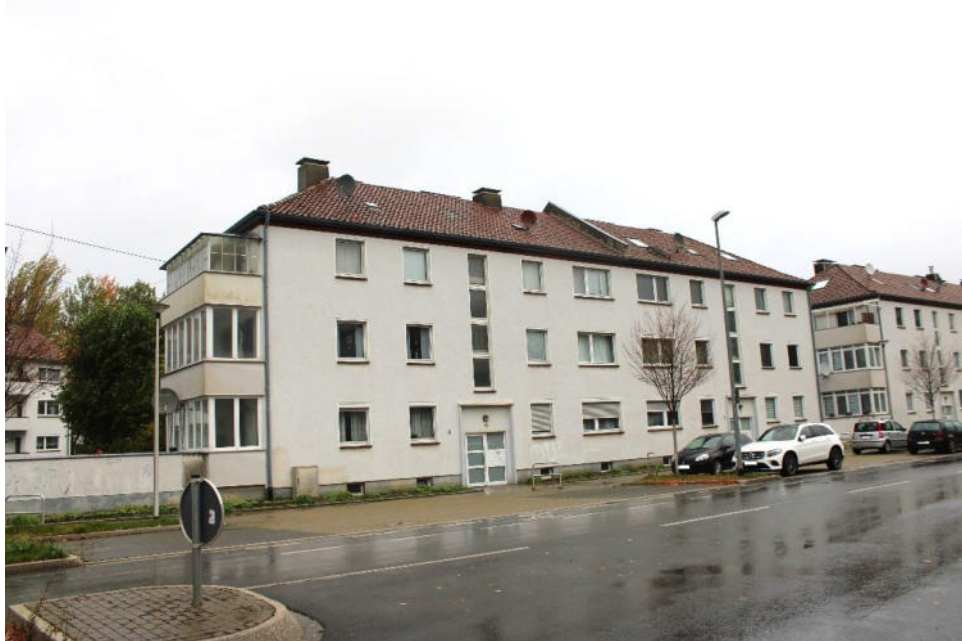
Bild 3: Straßenansicht Enneper Str. 166 u. 164 / Südostansicht und Südwestgiebel
