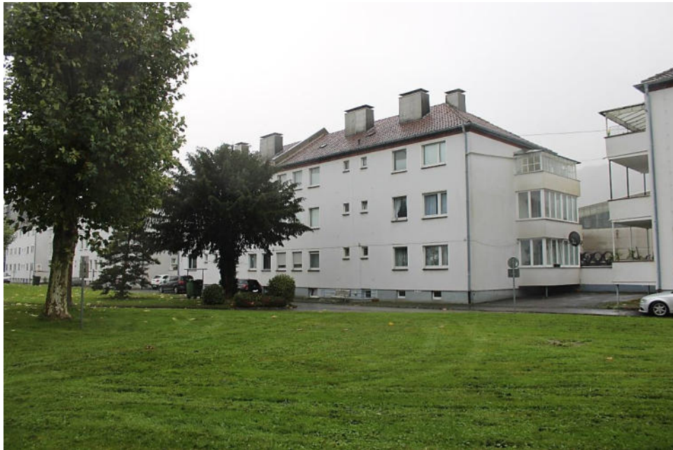
Bild 9: Rückansicht Norwestansicht und südwestliche Giebelseite Haus 166 / Grünflächen
