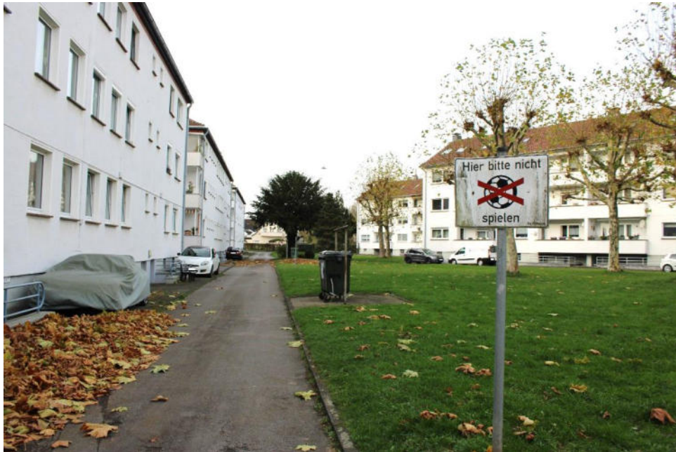
Bild 7: rückseitige Wege- und Grünflächen / Nordwestansicht Häuser 162 bis 170 und Südostansichten 166a u. 170a
