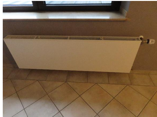
Zentral über einen Speicher mit Unterstützung durch Solarthermie
