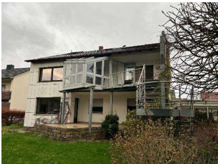
Südostansicht (Rückansicht) des Zweifamilienhauses mit Doppelgarage
