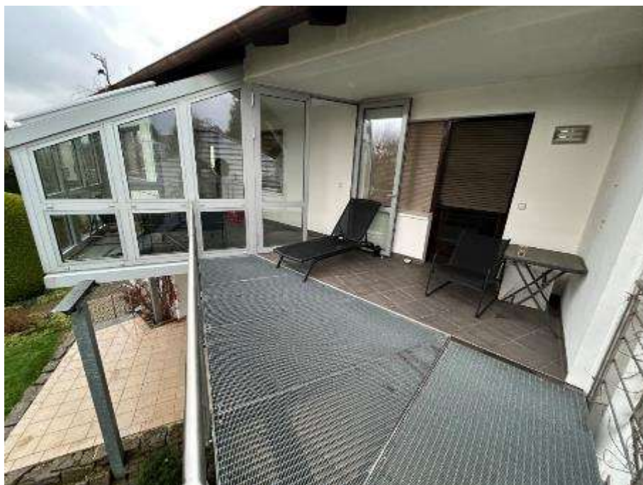
Ostansicht des Balkons mit Wintergarten
