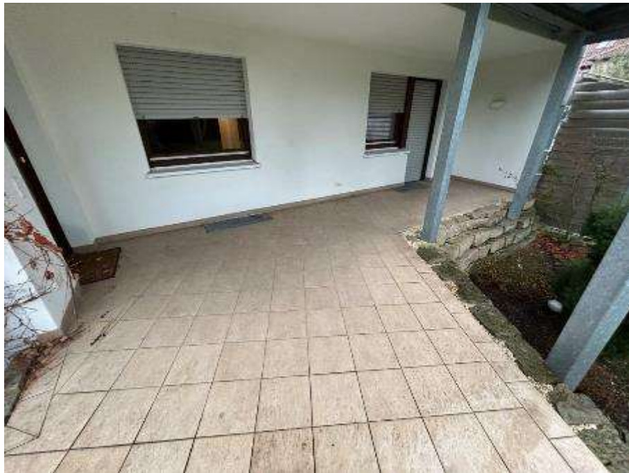
Südwestansicht der Terrasse
