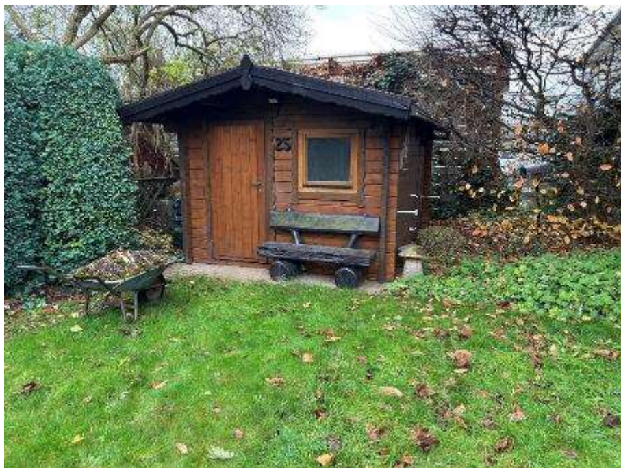
Nordwestansicht des Gartenhauses
