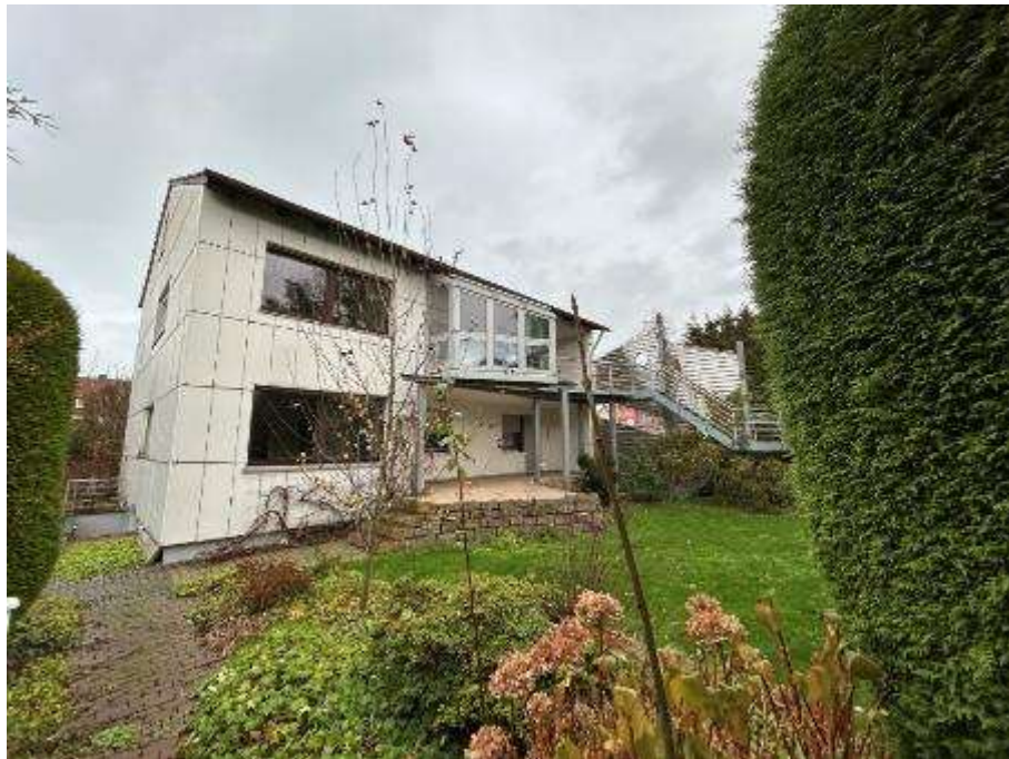
Südwestansicht (Rückansicht) des Zweifamilienhauses
