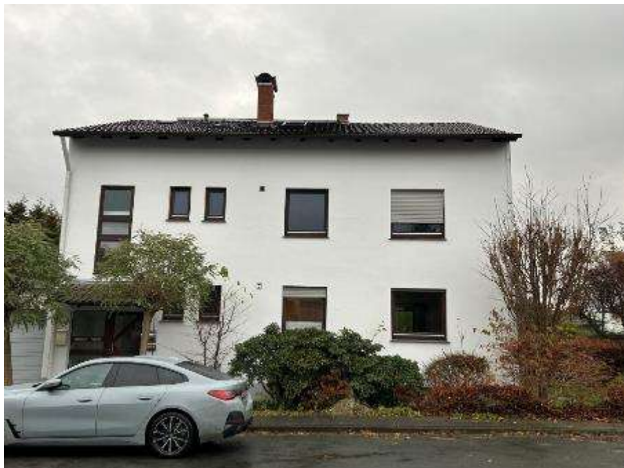
Nordansicht (Straßenansicht) des Zweifamilienhauses
