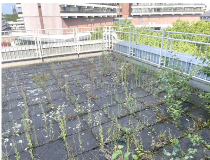
Wohnung Nr. 37 - Dachterrasse
