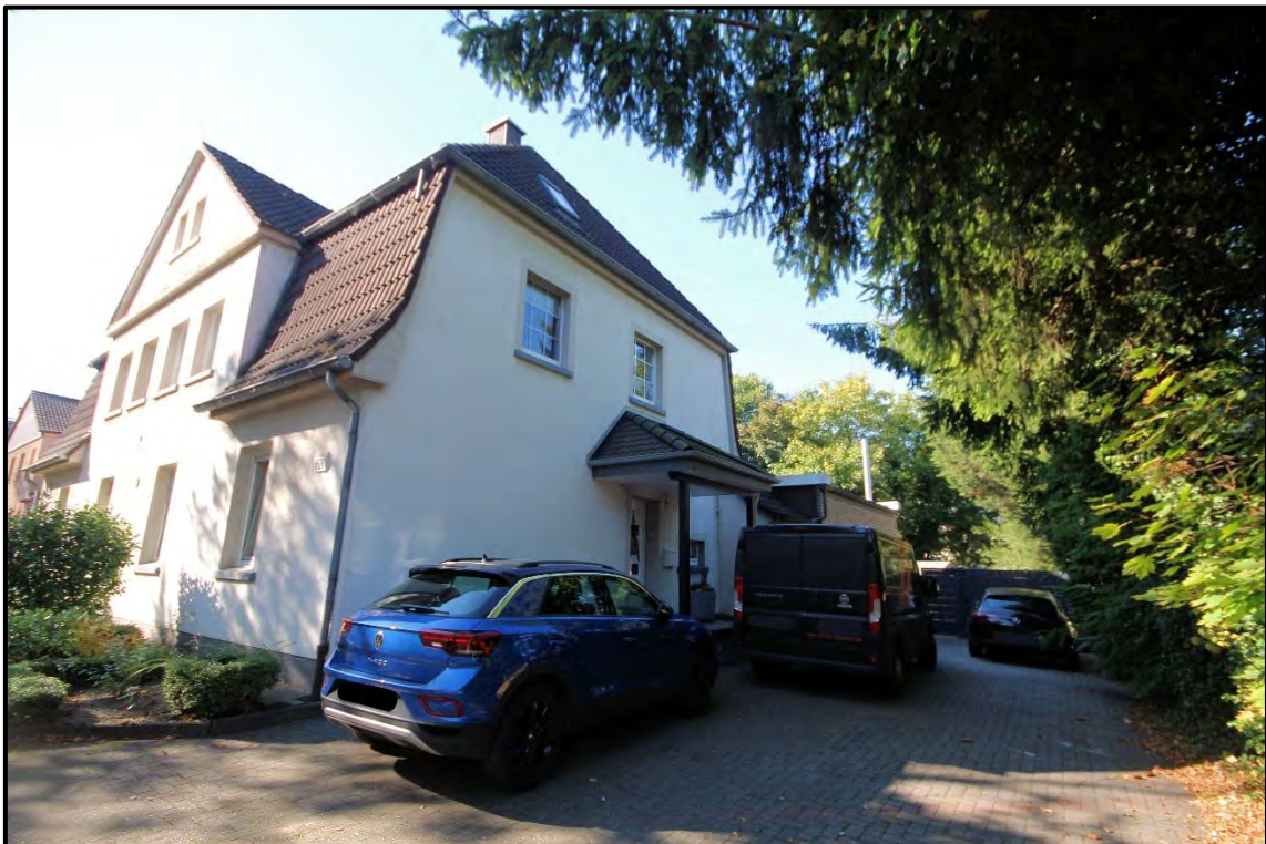
Bild 4: Ansicht von Nordosten
