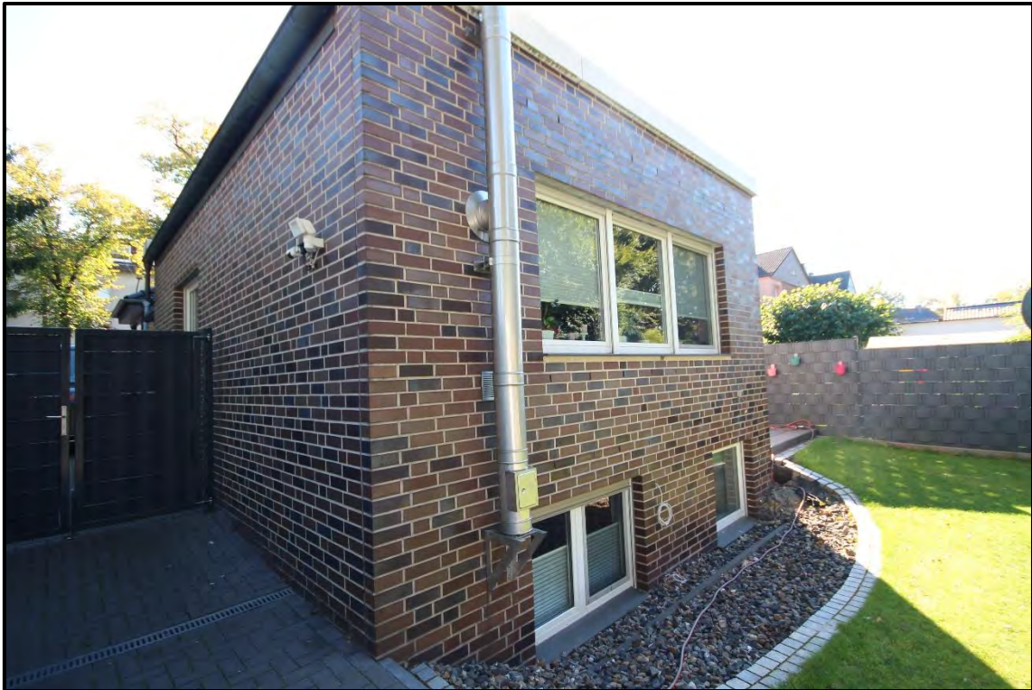
Bild 10: Ansicht des Anbaus von Nordwesten
