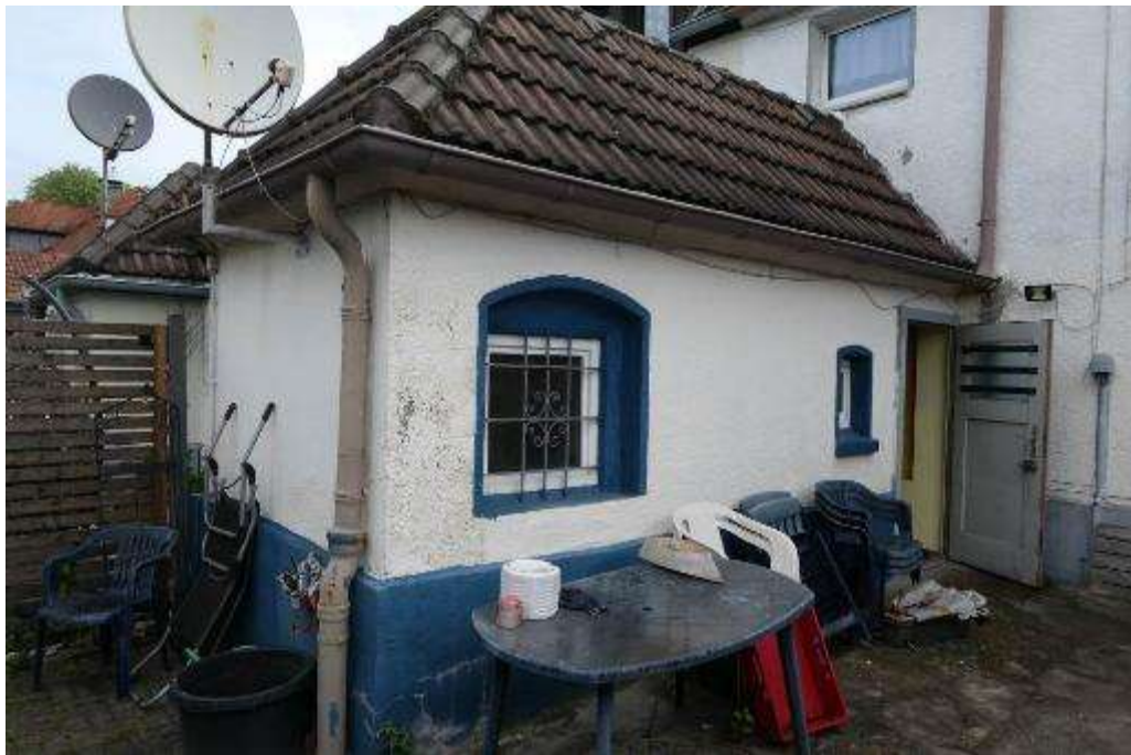
Bild 5 rückwärtiger Anbau mit Badezimmer
