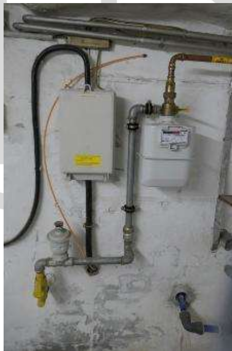
Bild 14 Hausanschlüsse, Glasfaseranschluss
