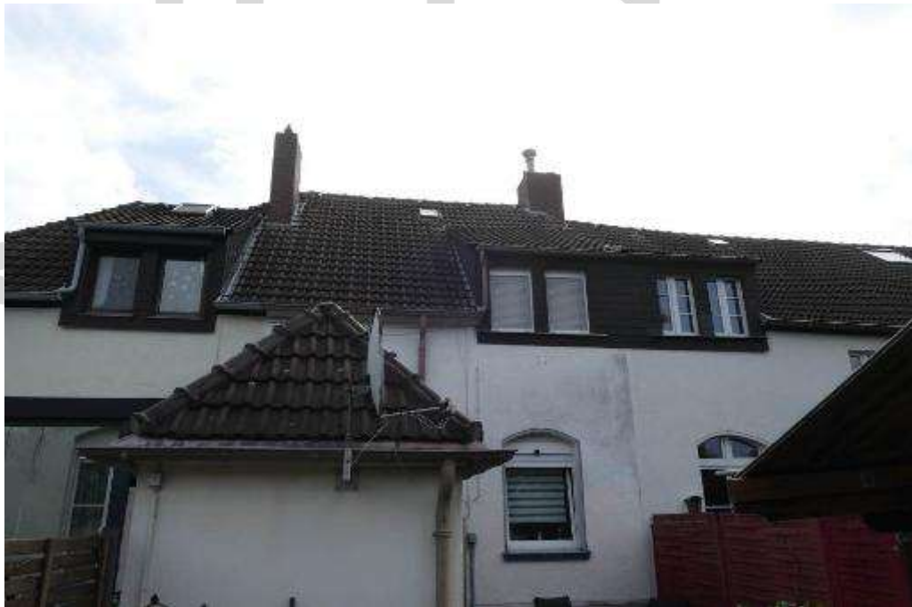
Bild 8 Blick auf die rückseitige Dachfläche
