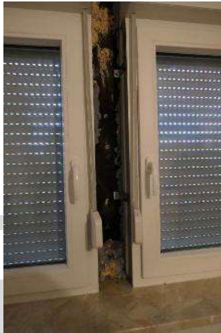
Bild 25 erneuerte Fenster im Dachgeschoss
