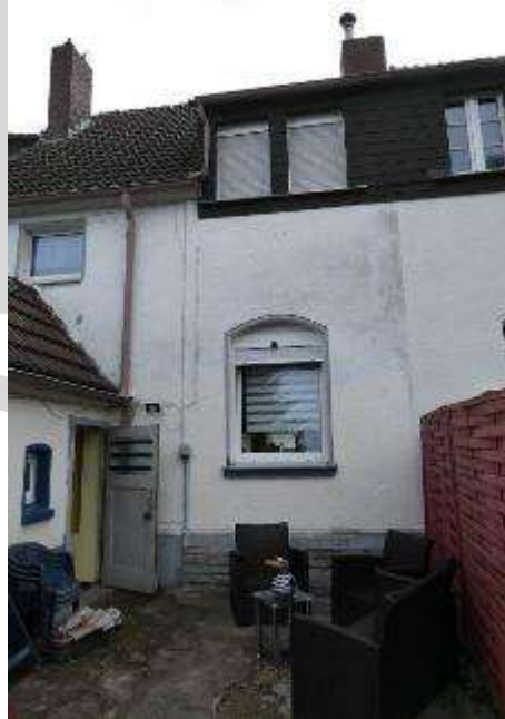
Bild 6 rückseitige Ansicht des Reihennittelhauses
