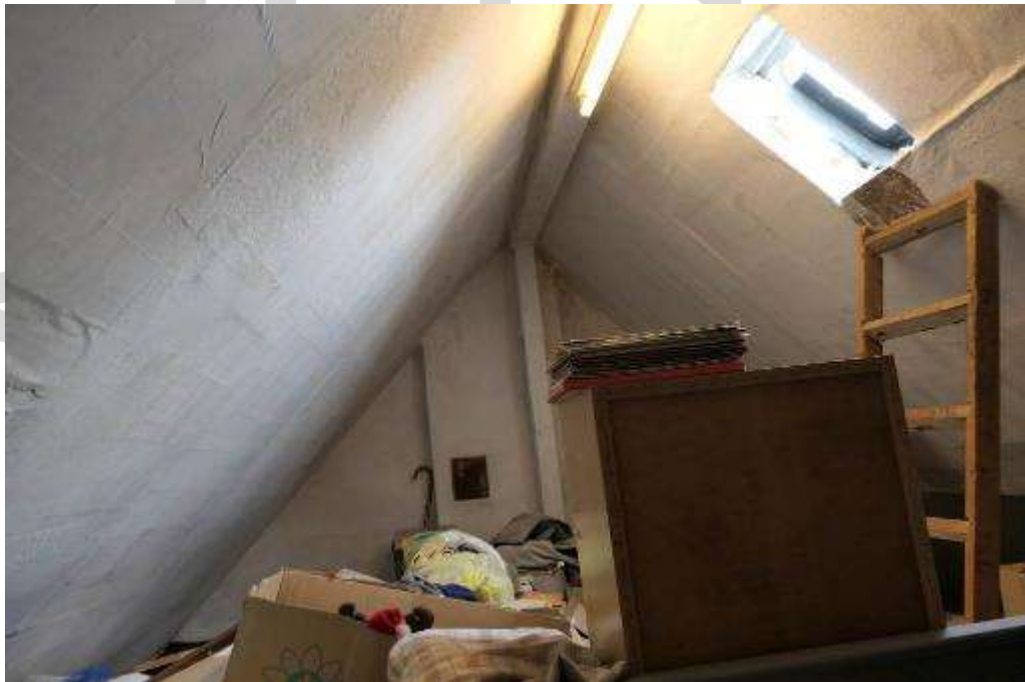
Bild 26 Blick in den Dachraum
