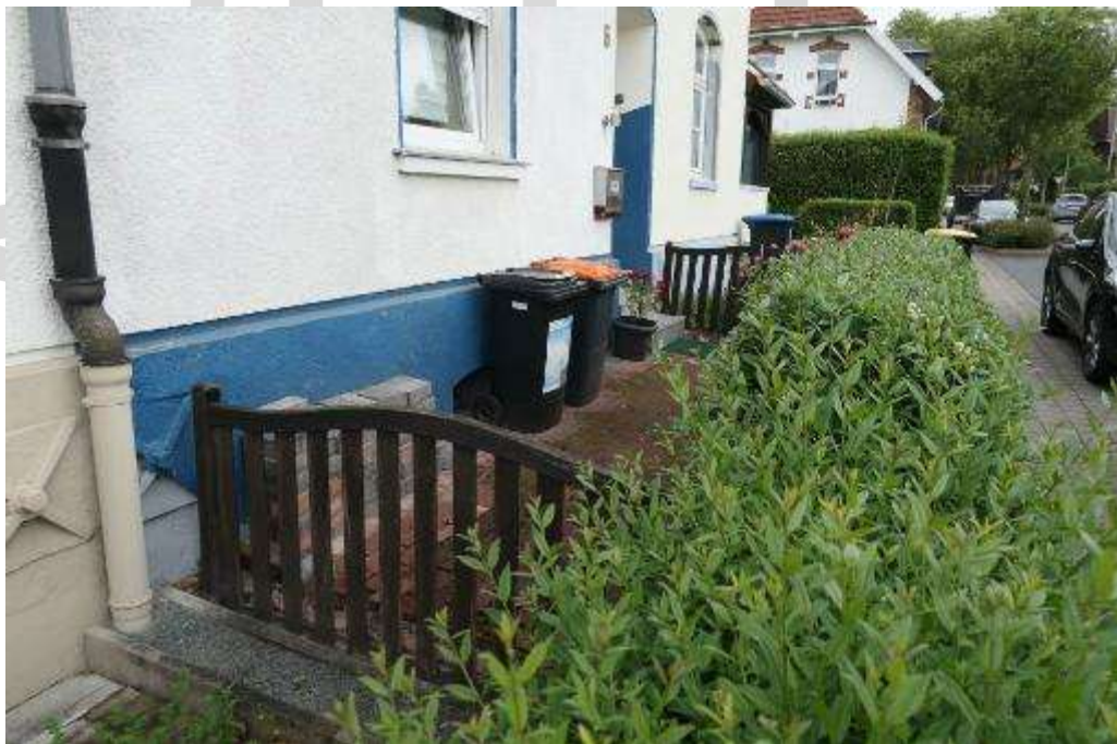
Bild 4 Vorgarten des Objekts
