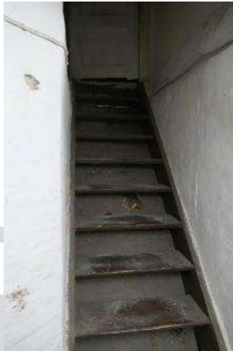
Bild 11 Geschosstreppe zum Keller
