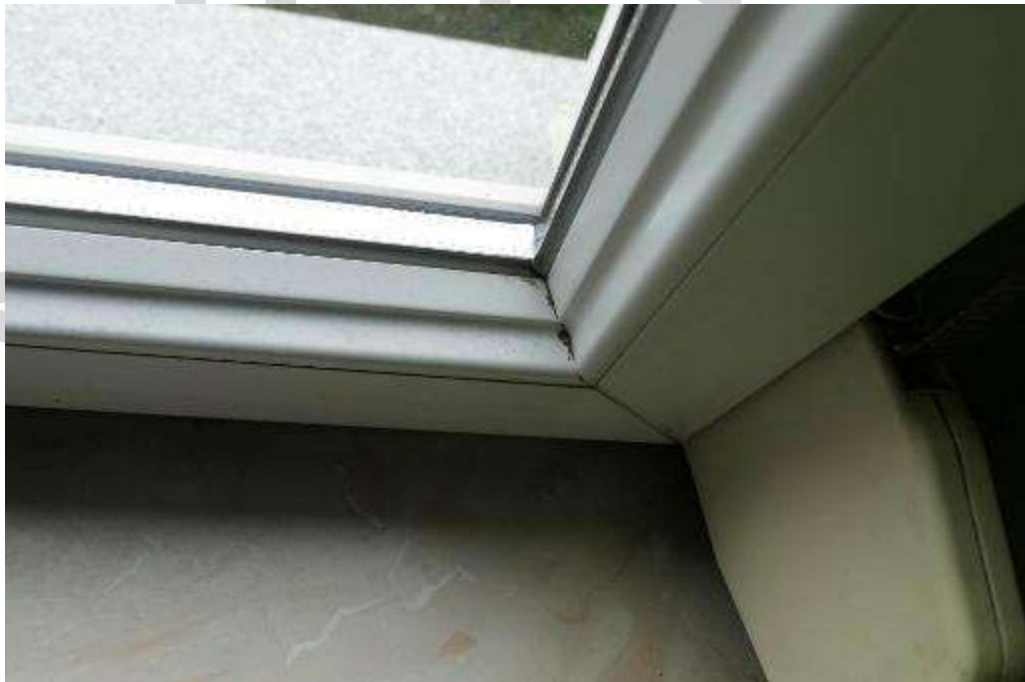
Bild 16 Kunststofffenster mit ISO Glas
