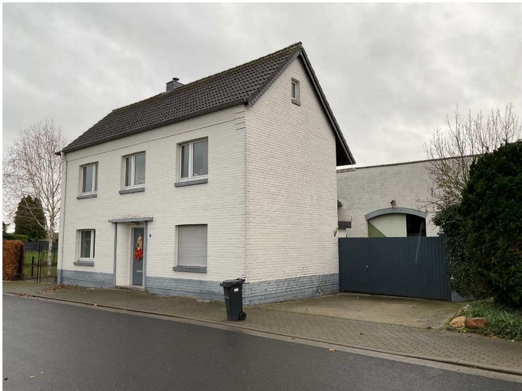
Bild 1: Profilansicht Wohnhaus und Hofansicht Scheune
