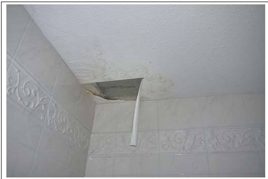
Souterrain – Wohnung Nr. 1 – Bad
