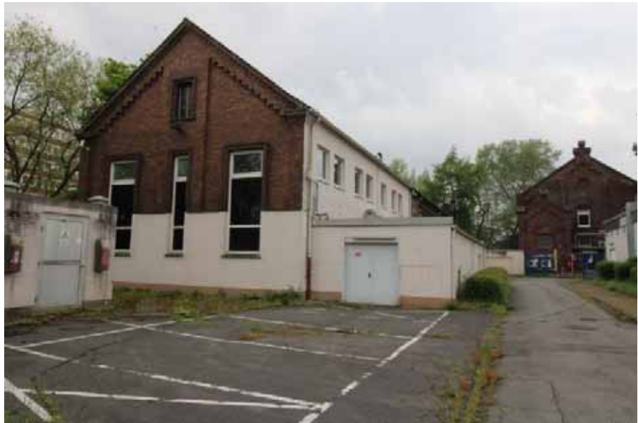
Sicht auf die Ost- und Nordfassade von Haus 14
