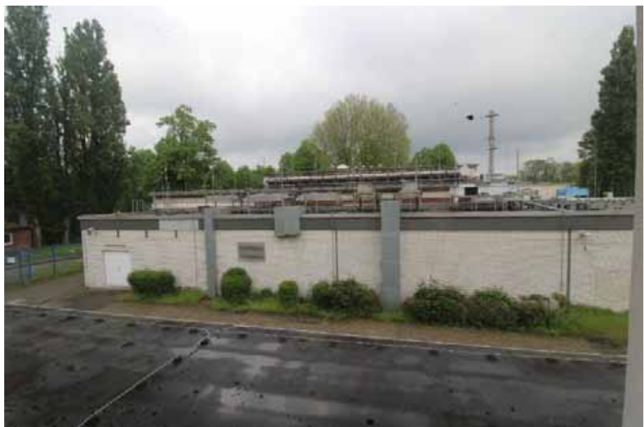
Blick vom Raum 7 aus über das Flachdach zum Haus 15 / OG Haus 14
