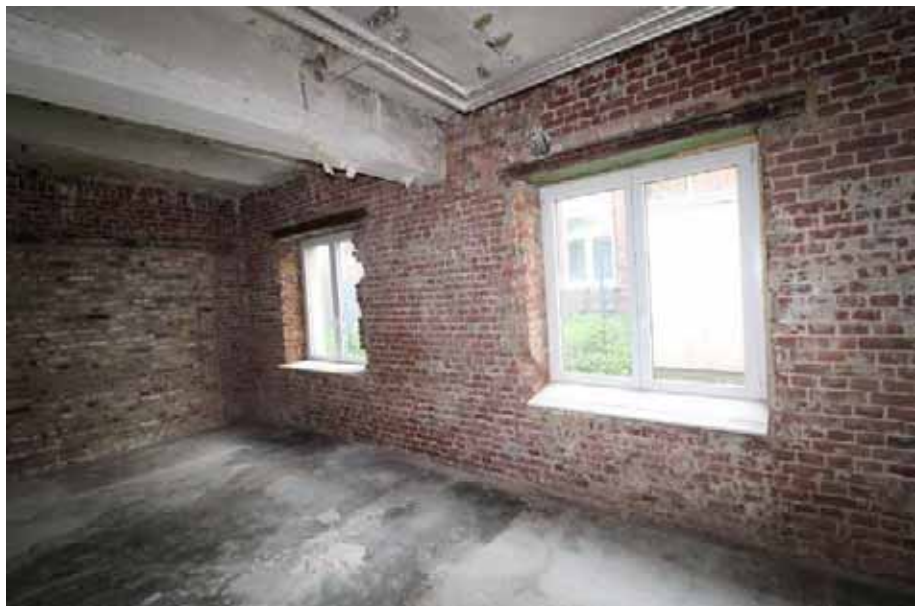
Sicht in Raum 1 / EG Haus 14
