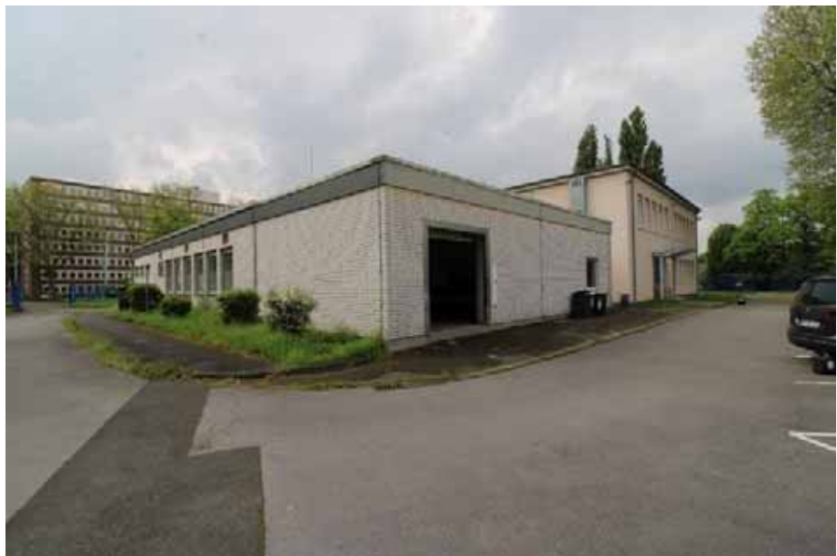
Sicht auf die Nord- und Ostfassade von Haus 15
