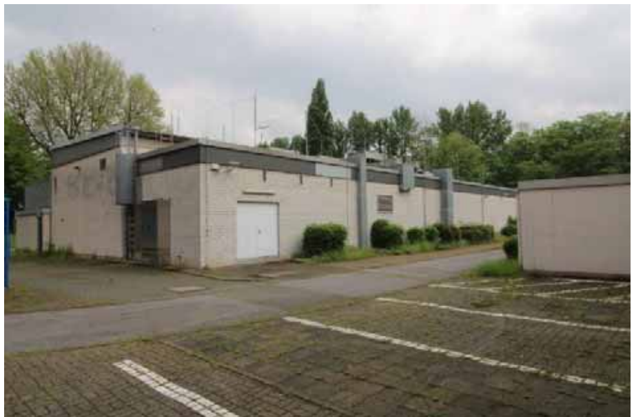
Sicht auf die Süd- und Westfassade von Haus 15
