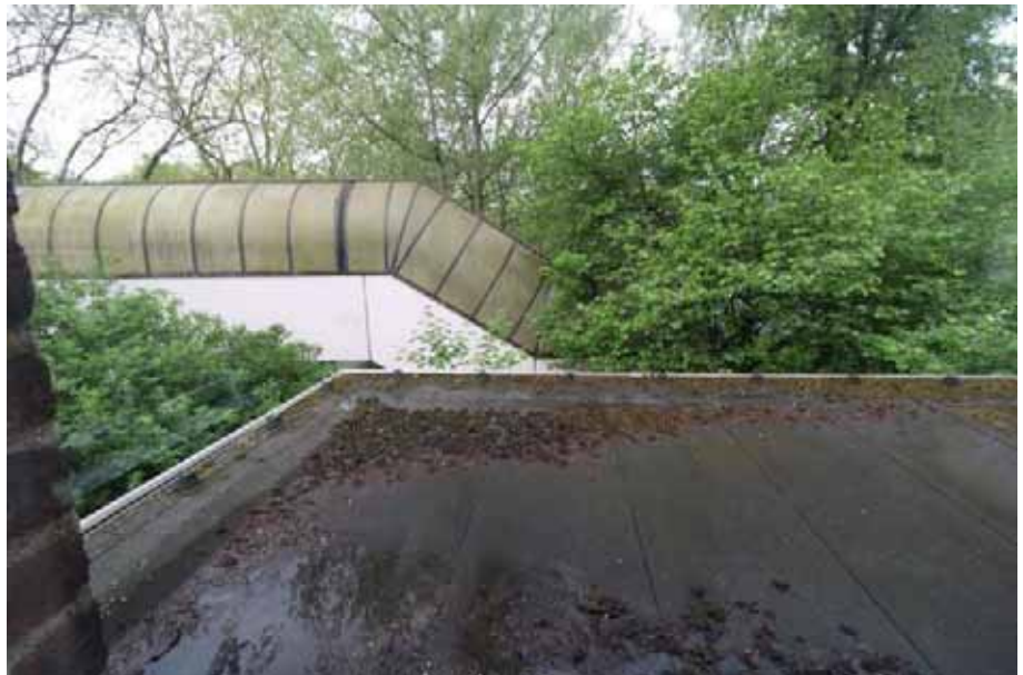
Sicht vom Raum 3 aus auf das Flachdach und die Fußgängerbrücke / OG Haus 14
