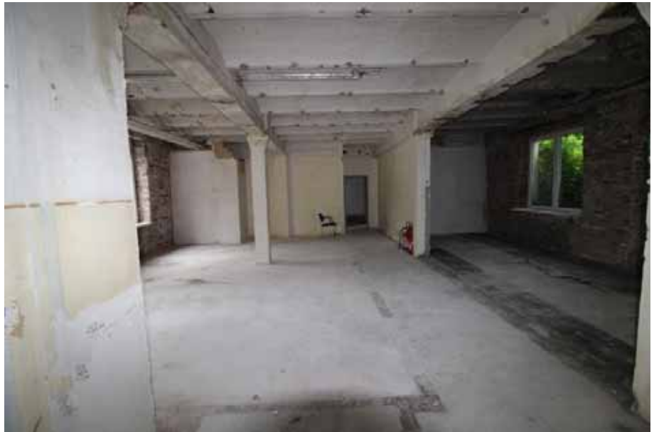
Sicht in Raum 1 / EG Haus 14
