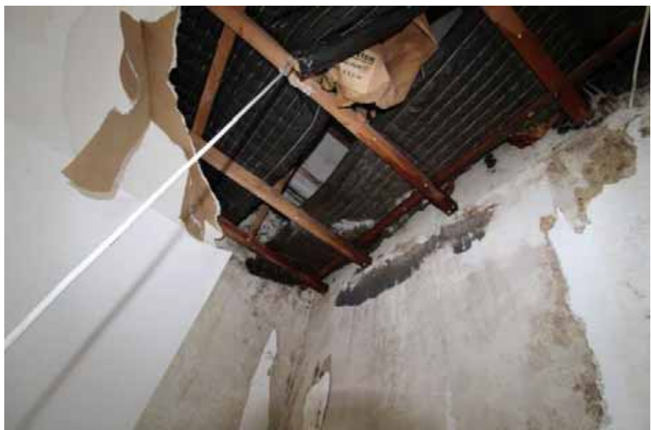
Sicht in den Raum 8 / EG Haus 17
