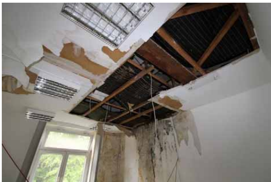
Sicht in den Raum 6 / EG Haus 17
