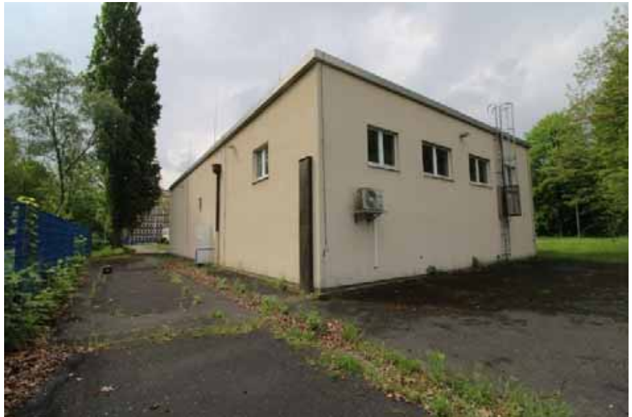
Sicht auf die Nord- und Ostfassade von Haus 16
