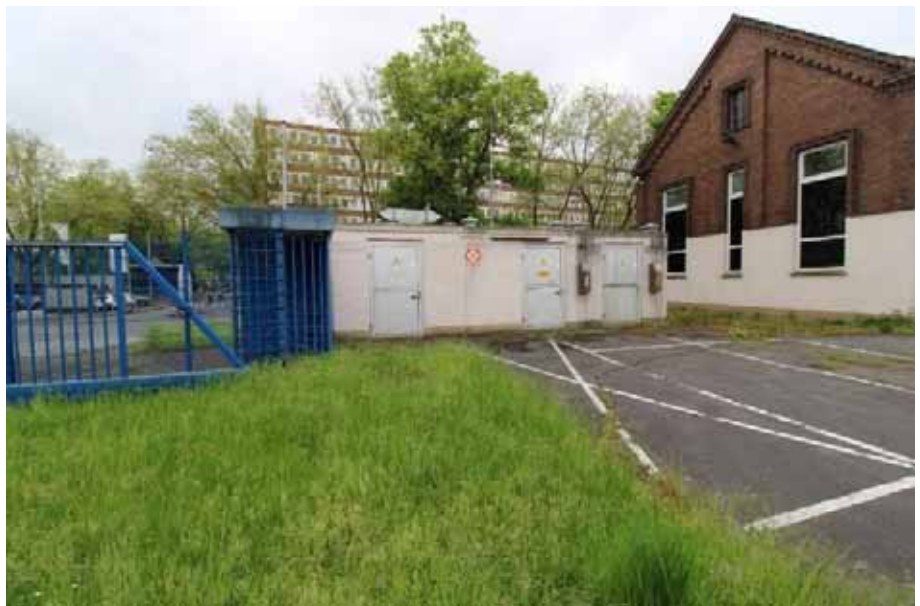
Sicht auf die Nordfassade von Haus 27
