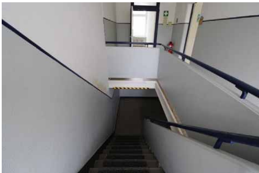
Sicht vom Flur aus auf den Treppenabgang / OG Haus 17
