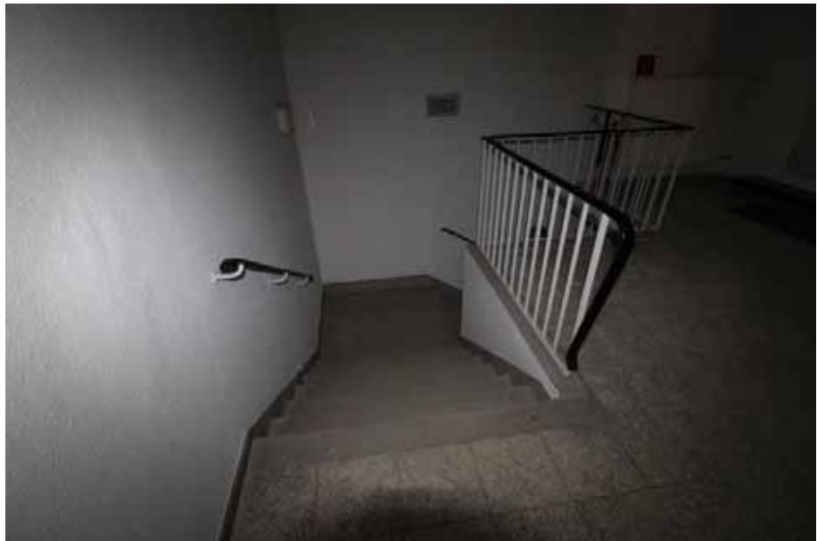
Sicht in den Treppen- raum mit Kellerabgang / EG Haus 15
