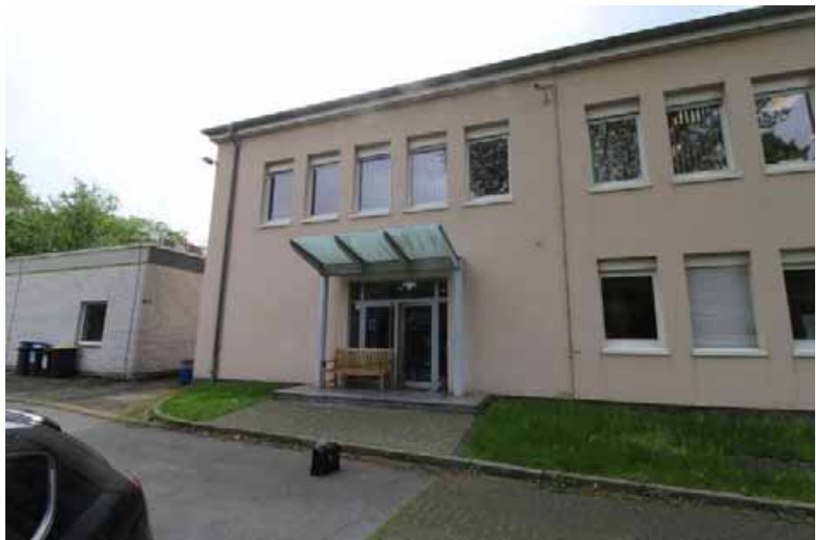
Sicht auf die Nordfassade von Haus 15
