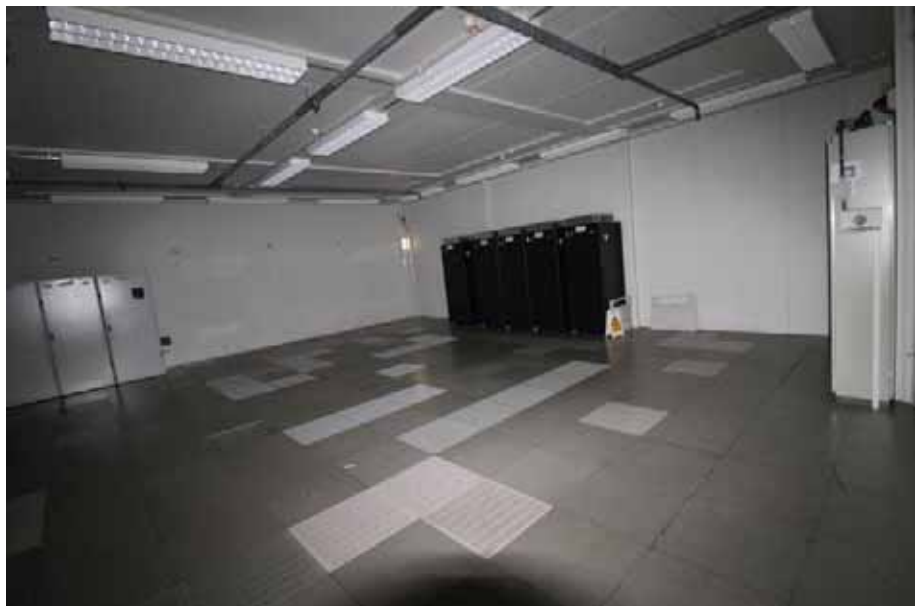
Sicht in einen Raum / EG Haus 16
