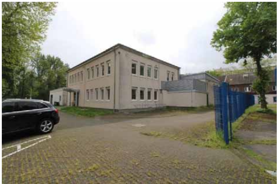
Sicht auf die West- und Nordfassade von Haus 15
