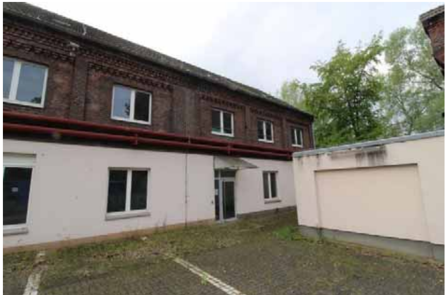
Sicht auf die Nordfas- sade von Haus 14
