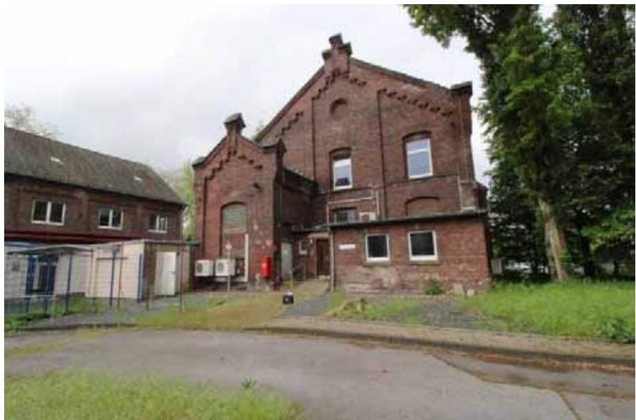
Sicht auf die Ostfas- sade von Haus 17
