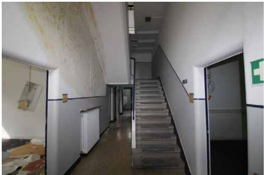
Sicht in den Flur / EG Haus 17
