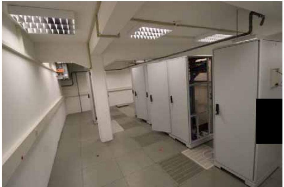
Sicht in einen Raum / EG Haus 16
