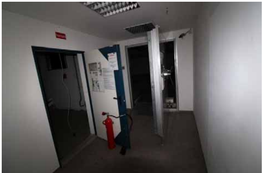
Sicht in den Flur 3 / EG Haus 14
