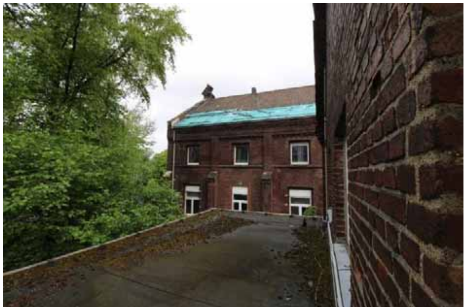
Sicht vom Raum 3 aus über das Flachdach zum Haus 17 / OG Haus 14
