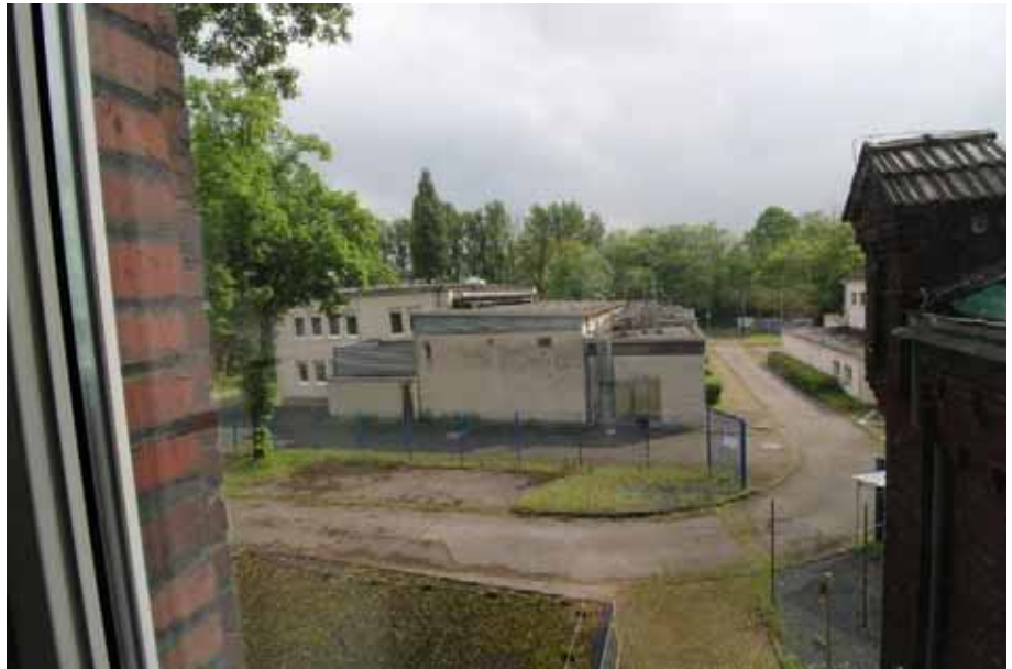
Sicht vom Flur aus zum Haus 15 / OG Haus 17
