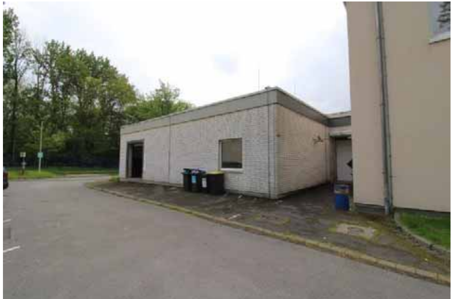
Sicht auf die Nordfas- sade von Haus 15
