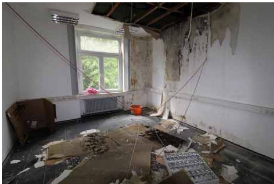
Sicht in den Raum 6 / EG Haus 17
