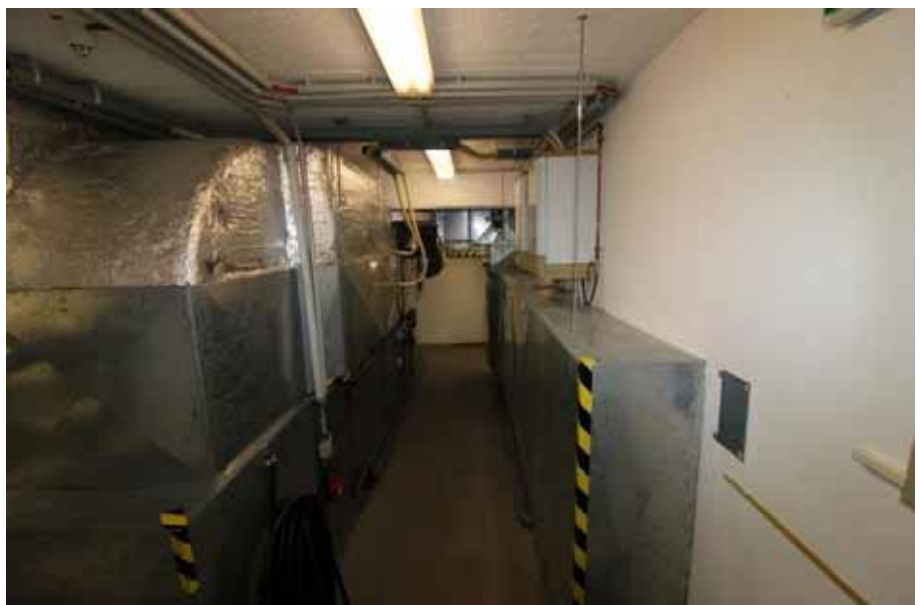
Sicht in einen Raum / EG Haus 16
