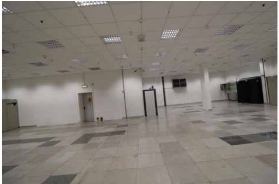
Sicht in den Rechner- raum / EG Haus 15
