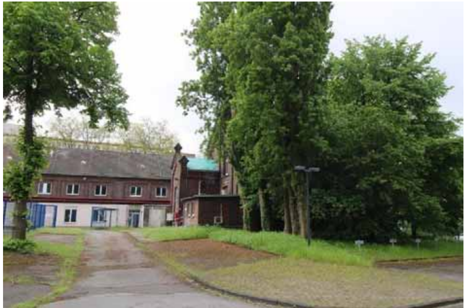
Sicht auf die Nordfas- sade von Haus 14
