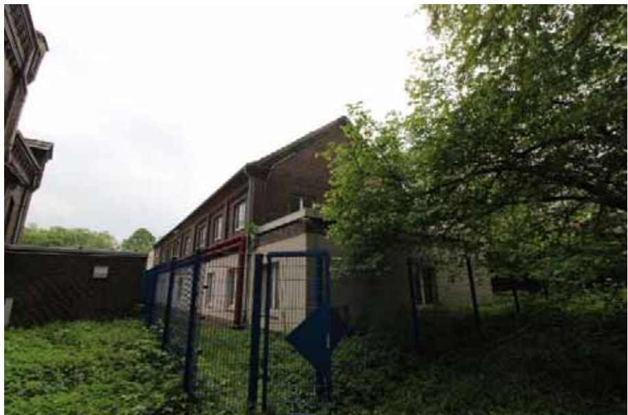
Sicht auf die West- und Nordfassade von Haus 14
