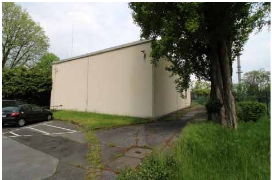
Sicht auf die Süd- und Ostfassade von Haus 16
