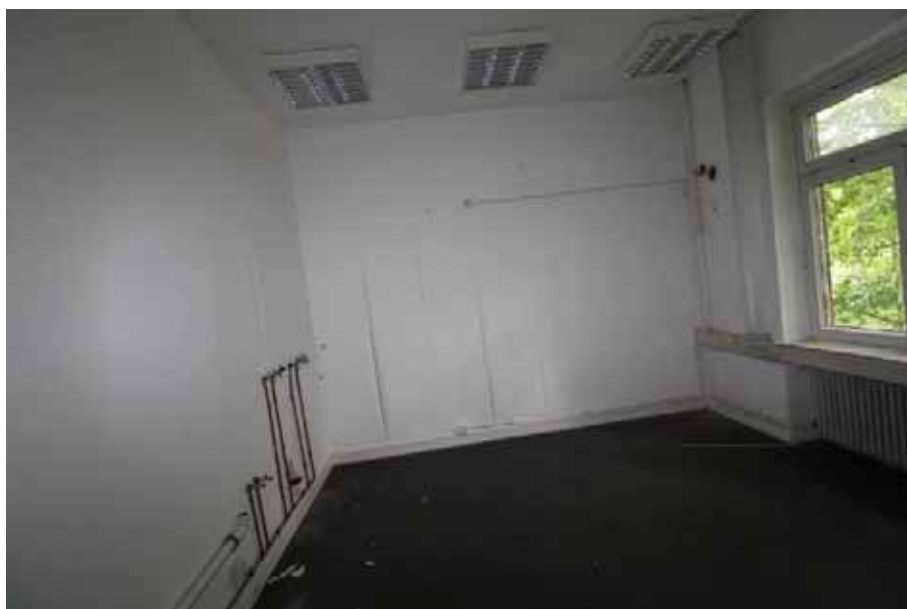
Sicht in den Raum 4 / EG Haus 17
