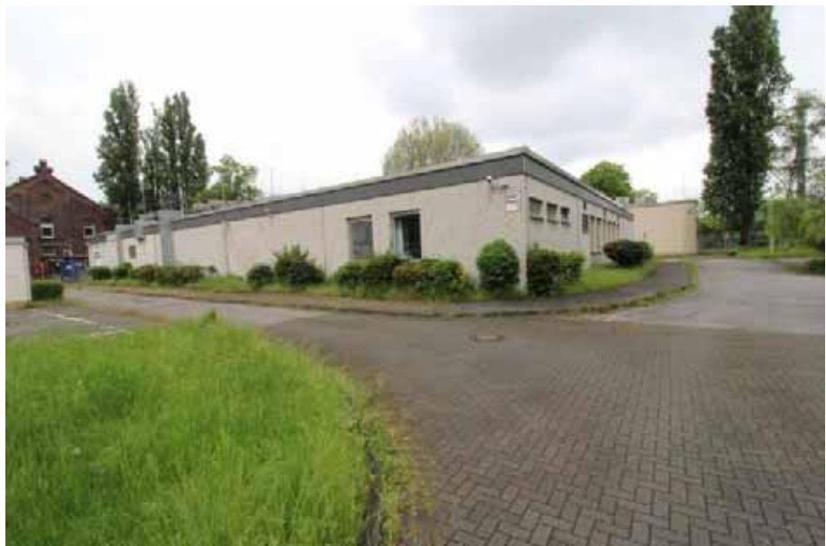
Sicht auf die Süd- und Ostfassade von Haus 15
