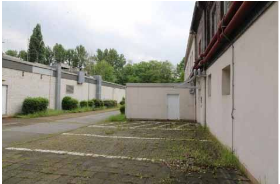
Sicht auf die Nordfas- sade von Haus 14 und die Südfassade von Haus 15
