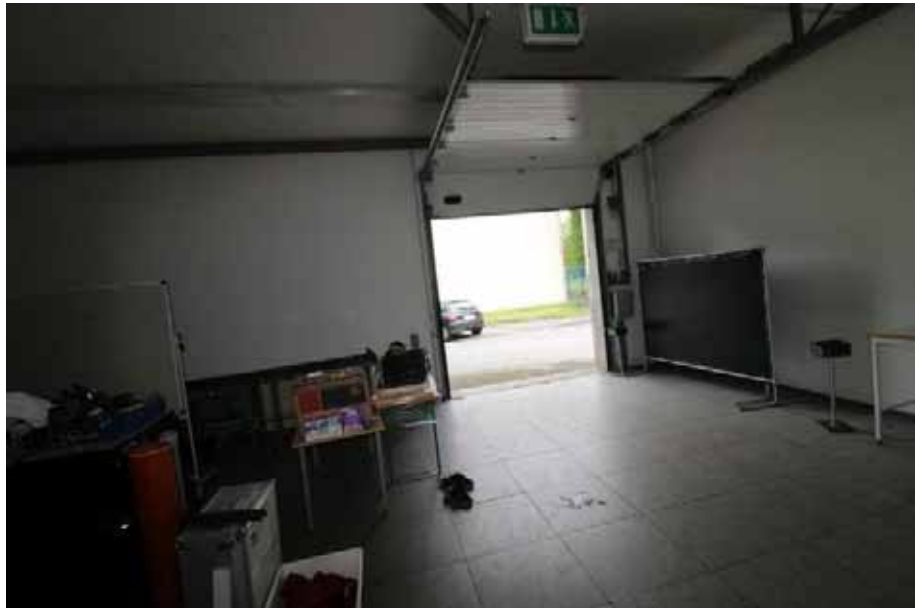
Sicht in den Vorraum / EG Haus 15
