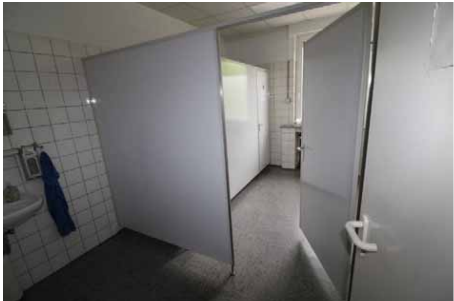
Sicht in das WC / OG Haus 15
