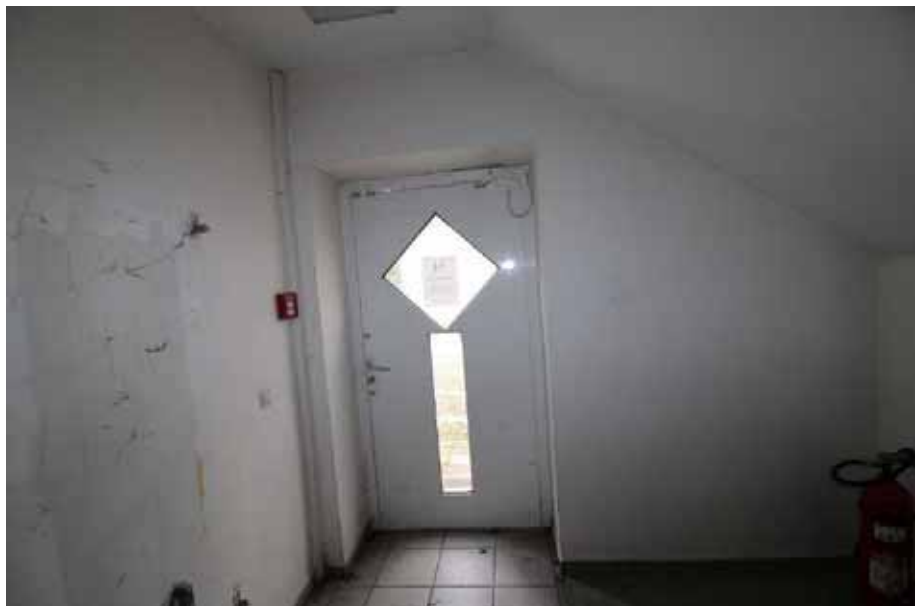
Sicht auf die Zugangs- tür zum Treppenhaus / EG Haus 14
