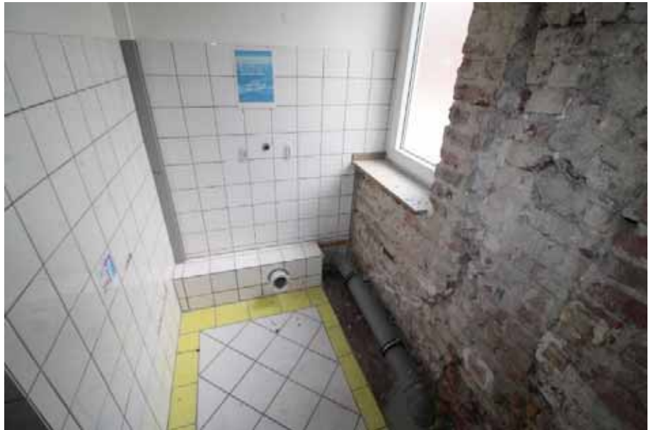
Sicht in ein WC / OG Haus 14
