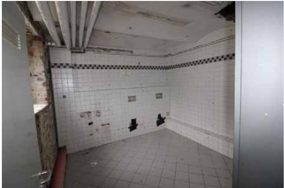
Sicht in das WC / EG Haus 14
