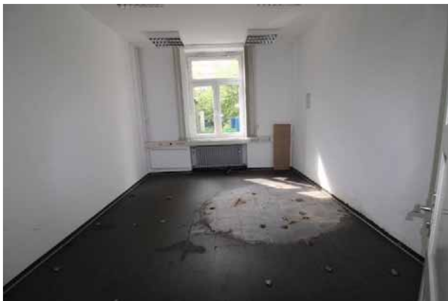
Sicht in den Raum 7 / EG Haus 17
