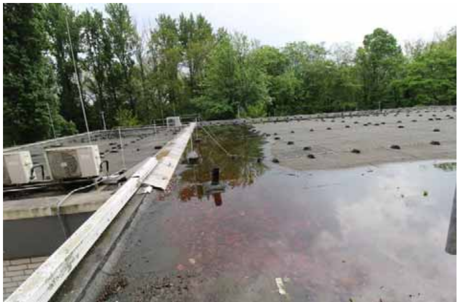
Sicht auf das Flach- dach / OG Haus 15
