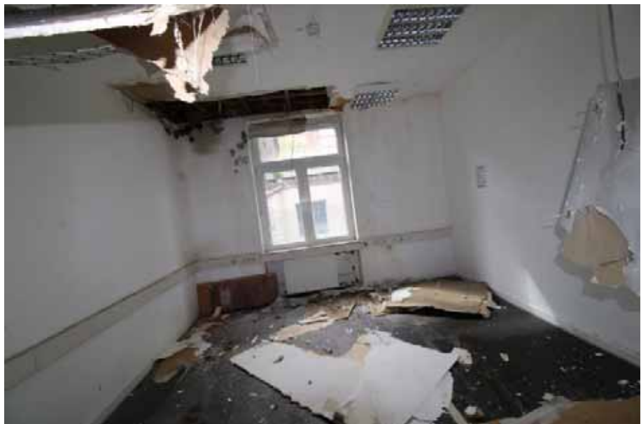
Sicht in den Raum 8 / EG Haus 17
