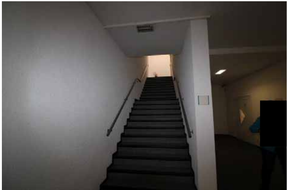
Sicht vom Flur 1 aus auf den Treppenauf- gang / EG Haus 15
