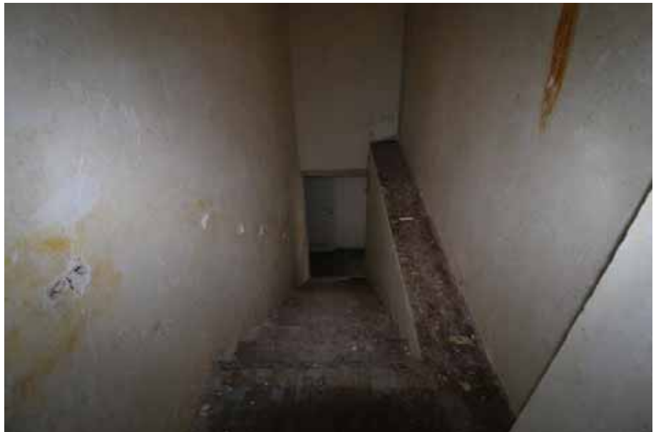
Sicht auf die Treppe / OG Haus 14
