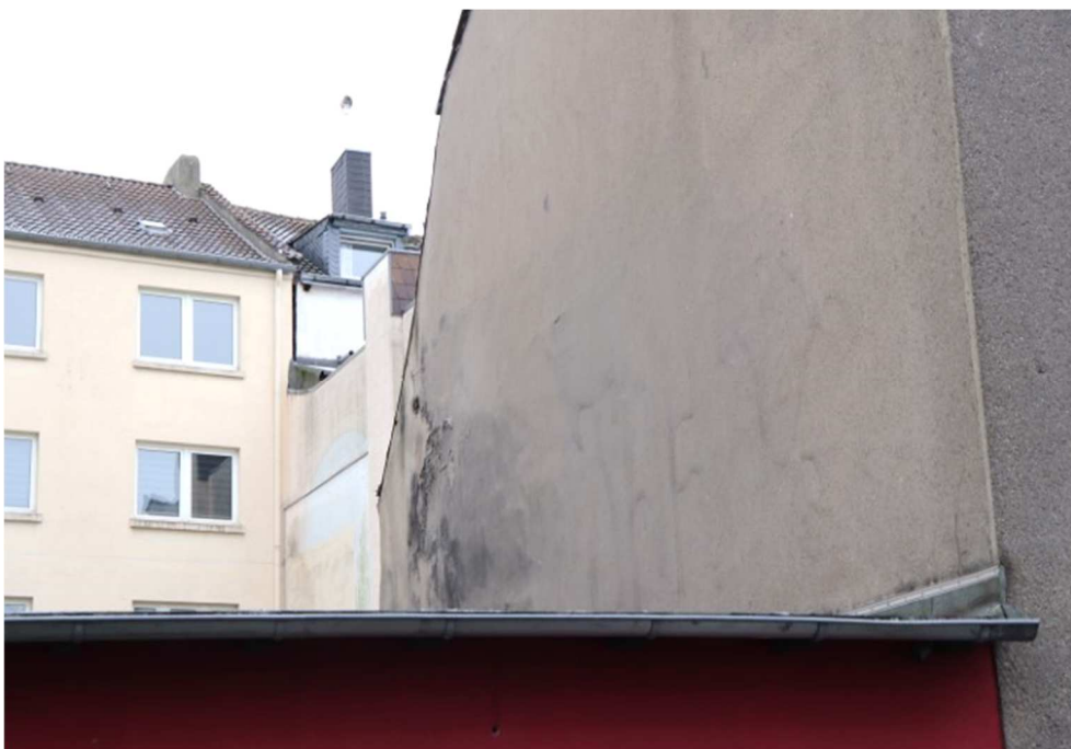
Bild 6 Feuchtigkeits-/Putzschäden an der freien Giebelseite im Außeneckbereich zur Hinterfront
