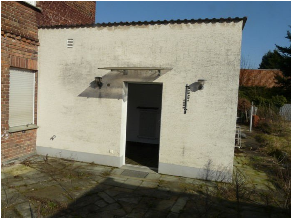
Teilansicht von Süden (Anbau)
