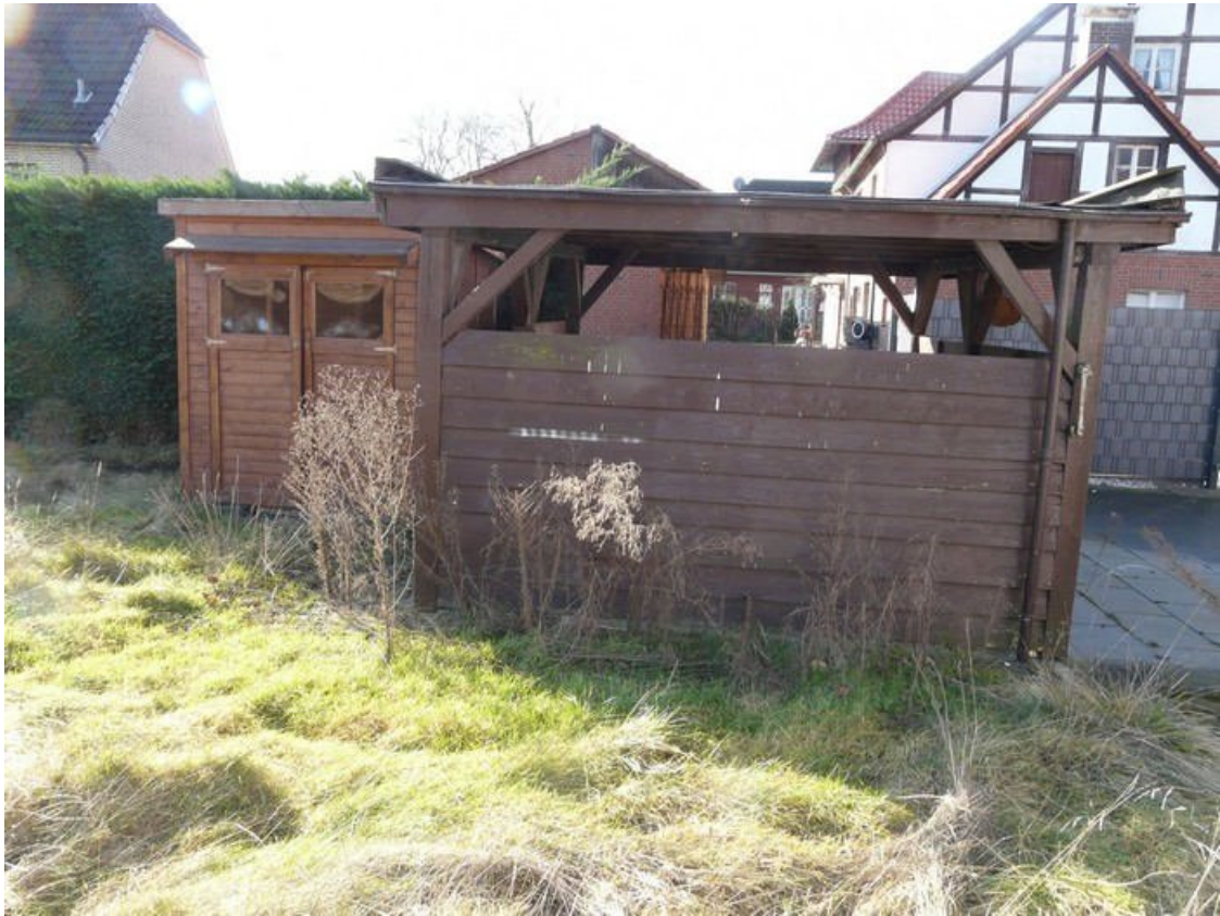
Ansicht von Norden (Carport)
