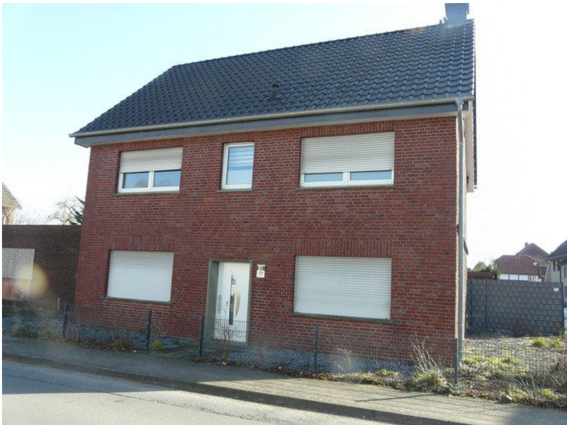
Teilansicht von Westen (Hauptgebäude)
