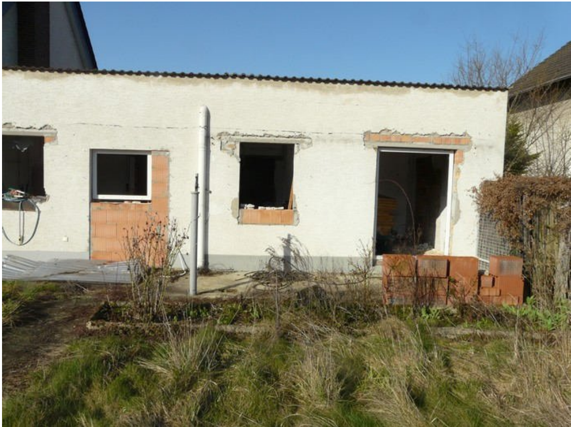
Teilansicht von Osten (Anbau)
