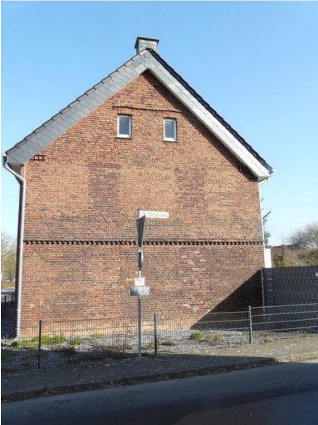
Teilansicht von Süden (Hauptgebäude)
