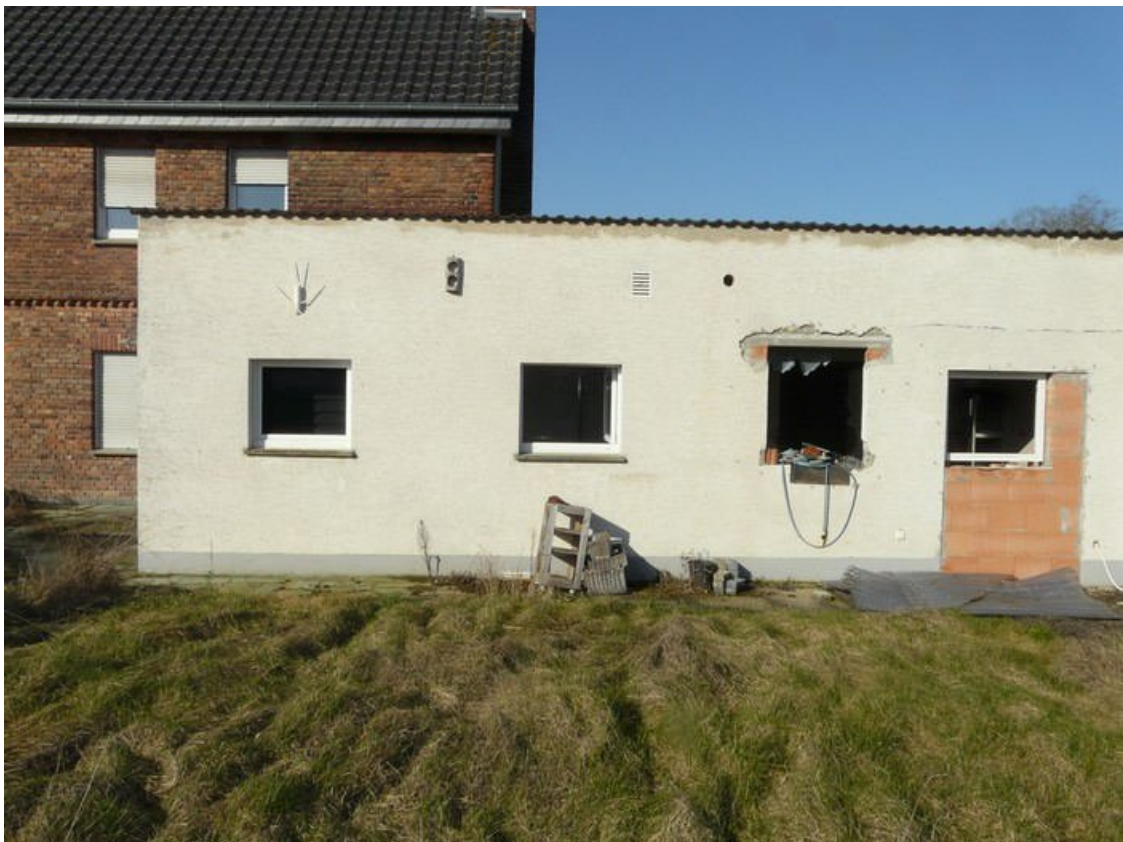
Teilansicht von Osten (Anbau)
