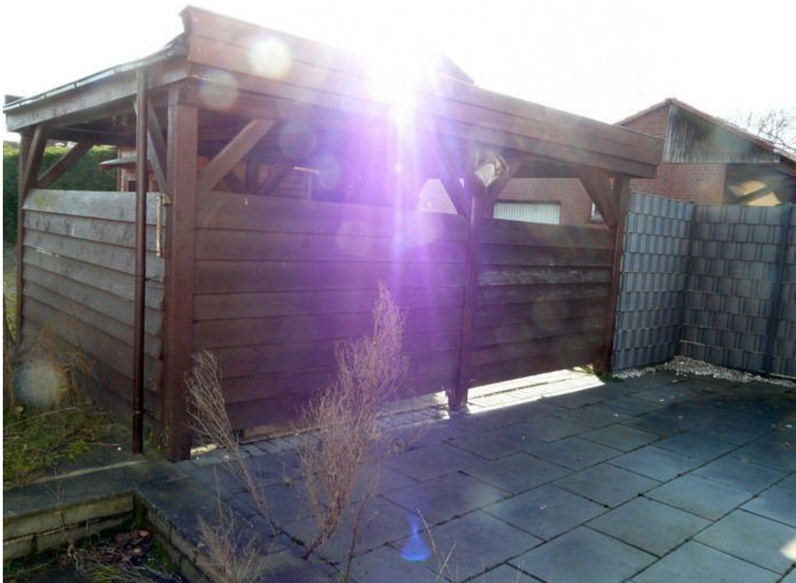
Ansicht von Nordwesten (Carport)
