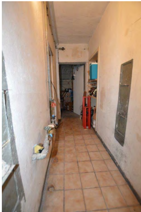
Unter-/ Kellergeschoss – Flur
