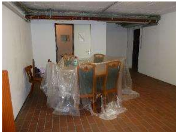
KG Hausnr. 86 Hobbyraum mit Abstellraum und Zugang zum Treppenhaus Hausnr. 86
