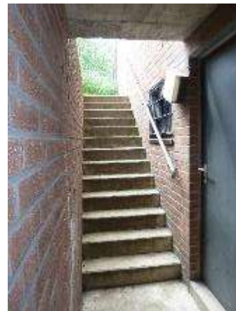
KG Kelleraußentreppe (2) zum Garten
