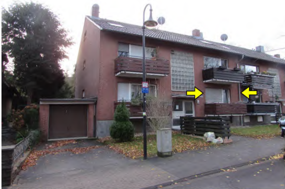
Foto 1: Mehrfamilienhaus "Schlangenfad 33", Hürth-Alt-Hürth, Eigentumswohnung Nr. 2
