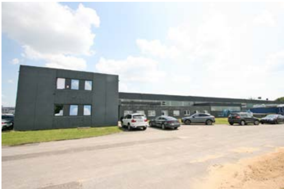
Bild 10: Seitenansicht des Bürogebäudes und der Hallen aus nordwestlicher Richtung
