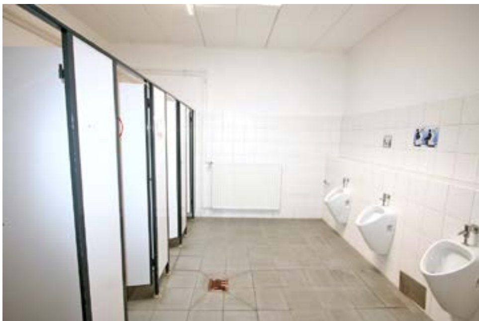
Bild 20: Herren-WC im eingeschossigen Anbau des Bürogebäudes
