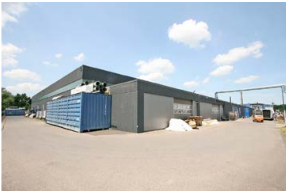
Bild 6: Ansicht der Hallen mit eingeschossigen Anbauten aus südlicher Richtung
