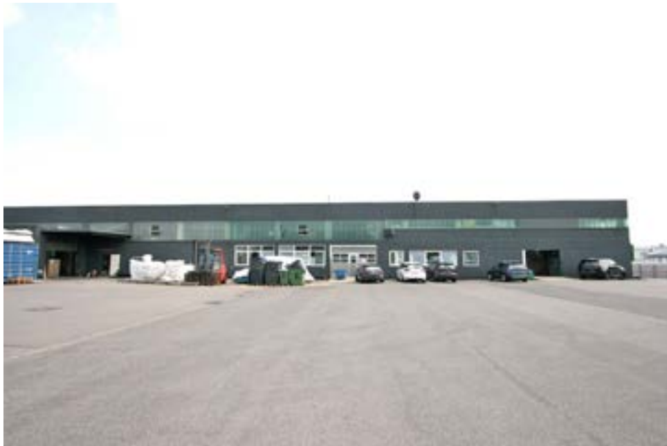
Bild 9: Seitenansicht der Hallen aus nordwestlicher Richtung
