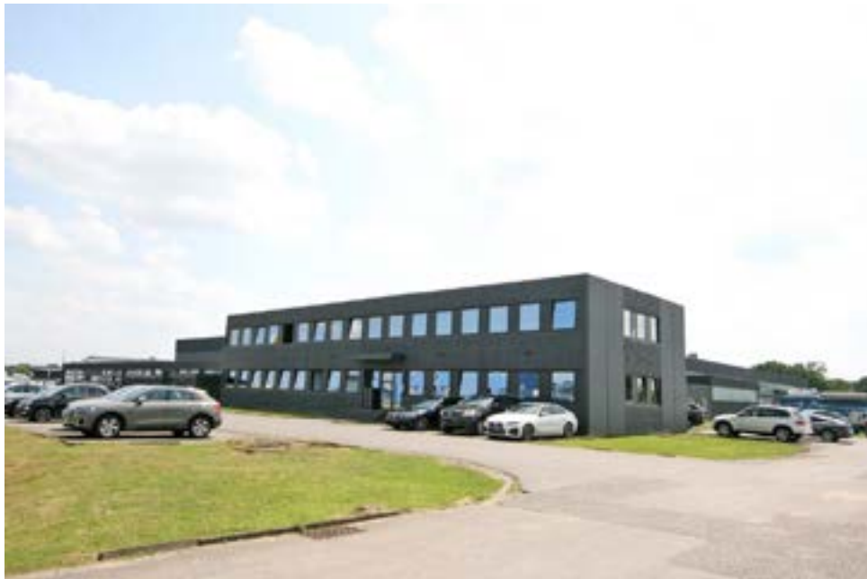
Bild 3: Ansicht des Bürogebäudes aus nördlicher Richtung
