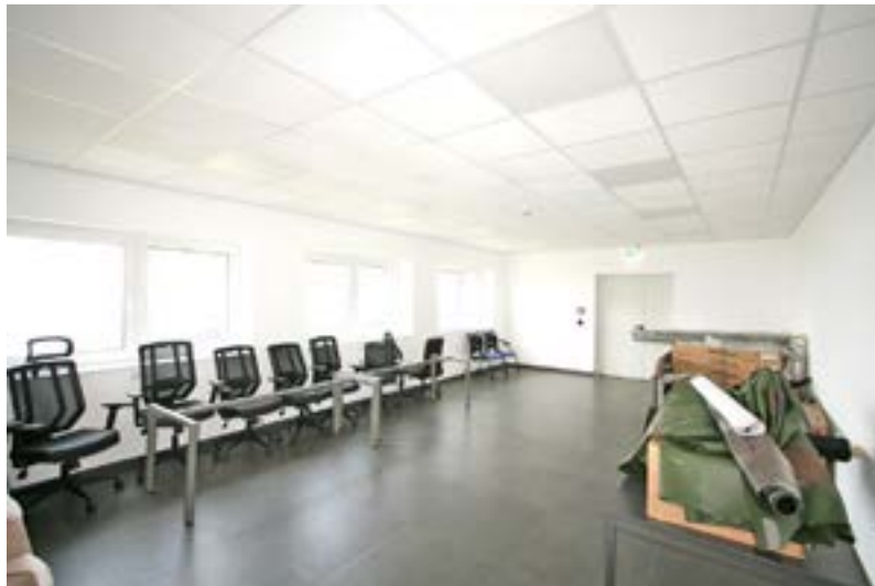
Bild 35: „Auftragsannahme" im Anbau (3. Bauabschnitt)
