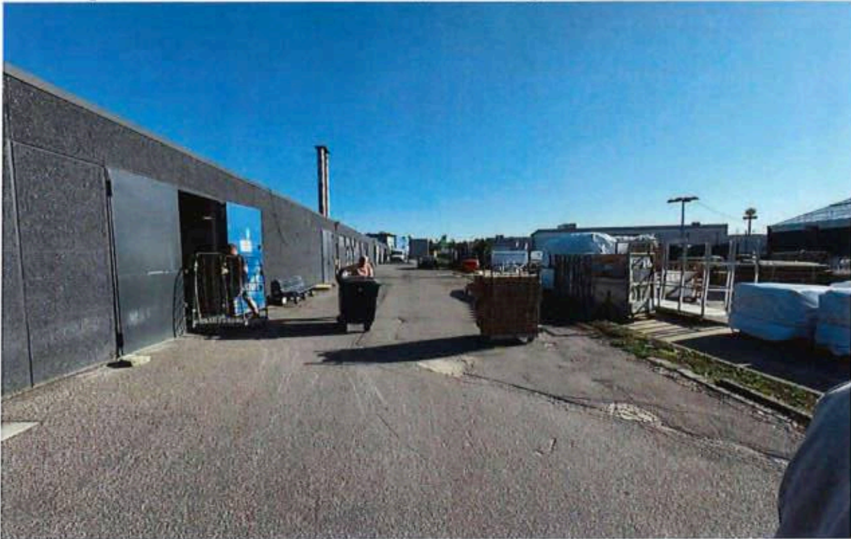
Entlüftung des unterflur vermuteten Heizöltanks, Blickrichtung Nord
