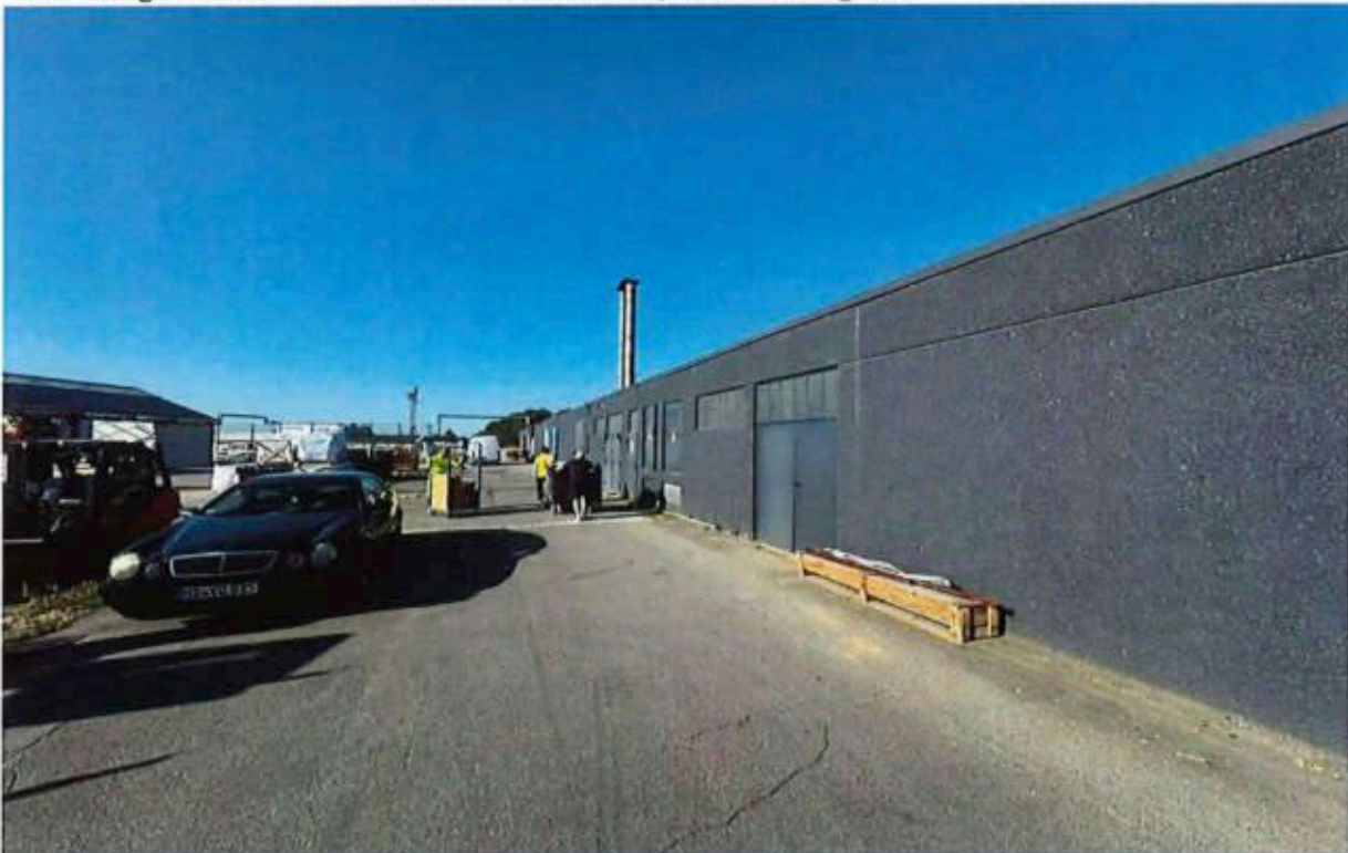
Entlüftung des unterflur vermuteten Heizöltanks, Blickrichtung Süd
