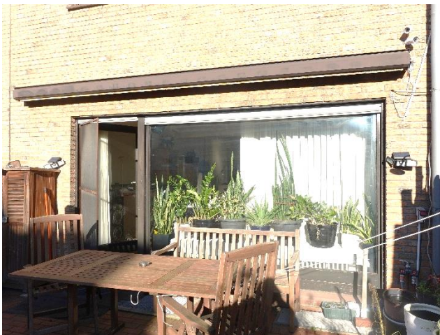
Bild 3 Terrasse zur Straßenseite
