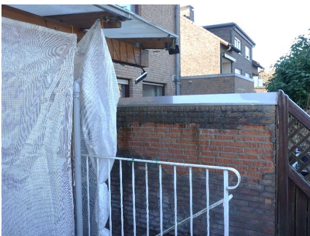
Bild 5 rückwärtige Terrasse /Kelleraußentreppe
