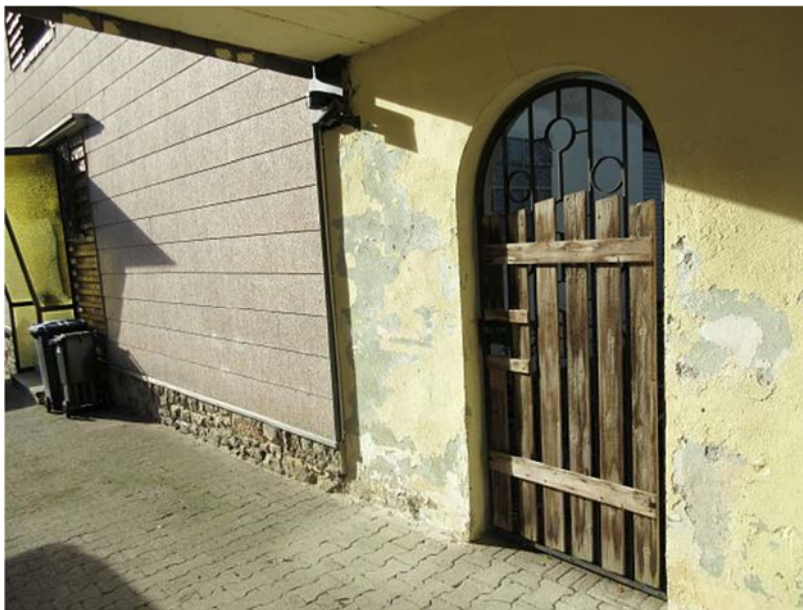
Trennwand mit Gartentor
