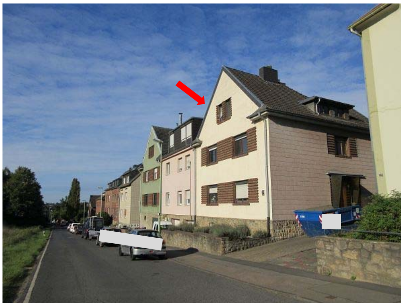
Straßenflucht Südwest mit Hausgruppe
