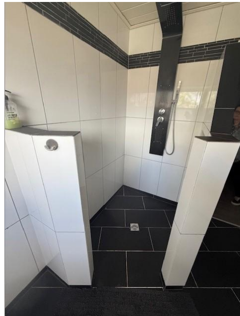
Bild 20: Bad, bodengleiche Dusche OG
