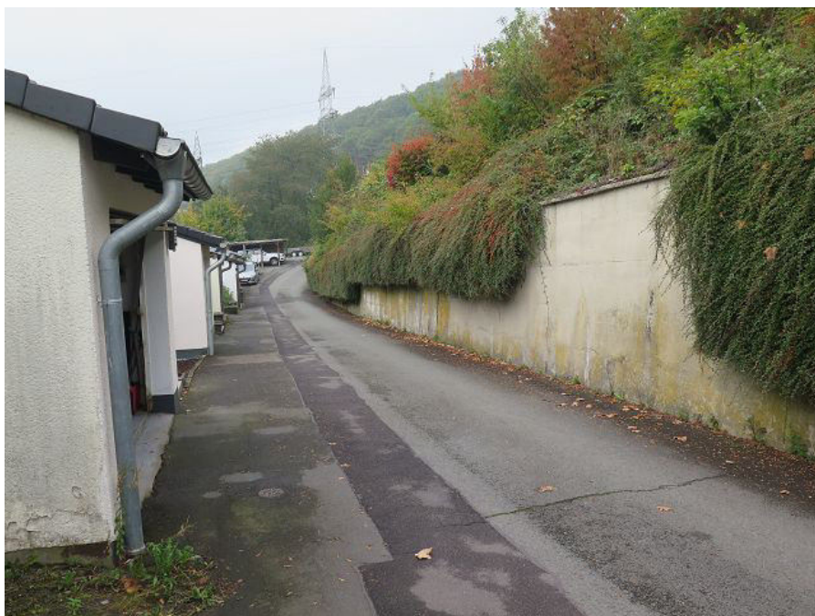
30) Gemeinschaftlicher Privatweg zur Erschließung der Grundstücke sowie Böschung mit Stützwand zur öffentlichen Straße
