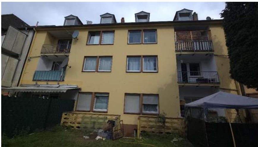
Gebäuderückseite mit Vermüllung im hinteren Grundstücksbereich. WE 4 befindet sich im 1.OG links.
