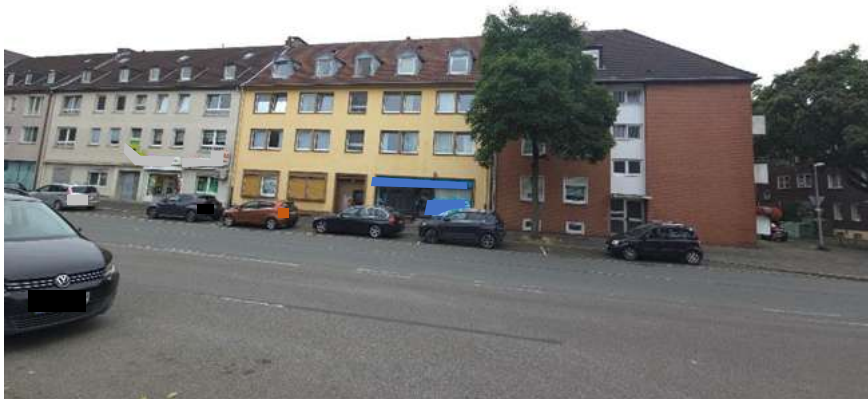
Straßenseitiger Blick auf das Wohn- und Geschäftshaus.
