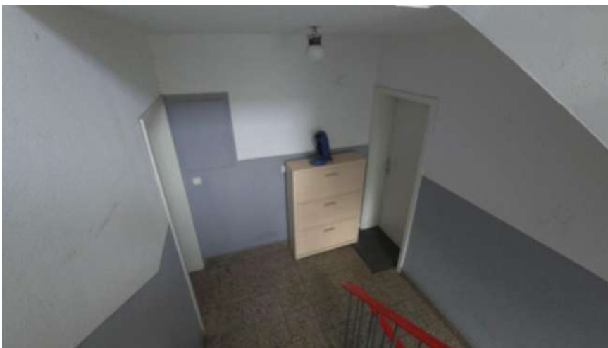
Treppenhauspodest im 1.OG mit Blick auf die Wohnungsabschlusstür zu WE 4 (rechts) und den Wandschrank mit Zählertafel und Sicherungsautomaten.
