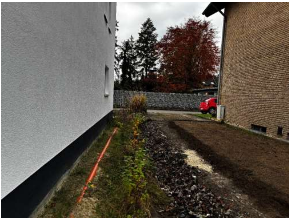
Bauwich, gemäß Planunterlagen vorgesehener Standort für Einzelgarage
