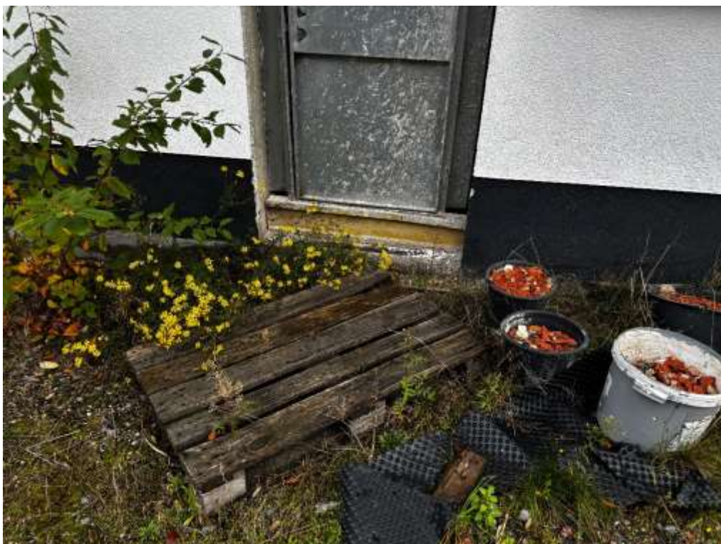
Eingangsbereich mit Bautür
