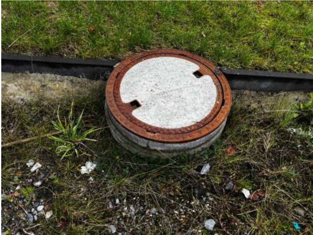
Schachtdeckel auf der Grundstücksgrenze
