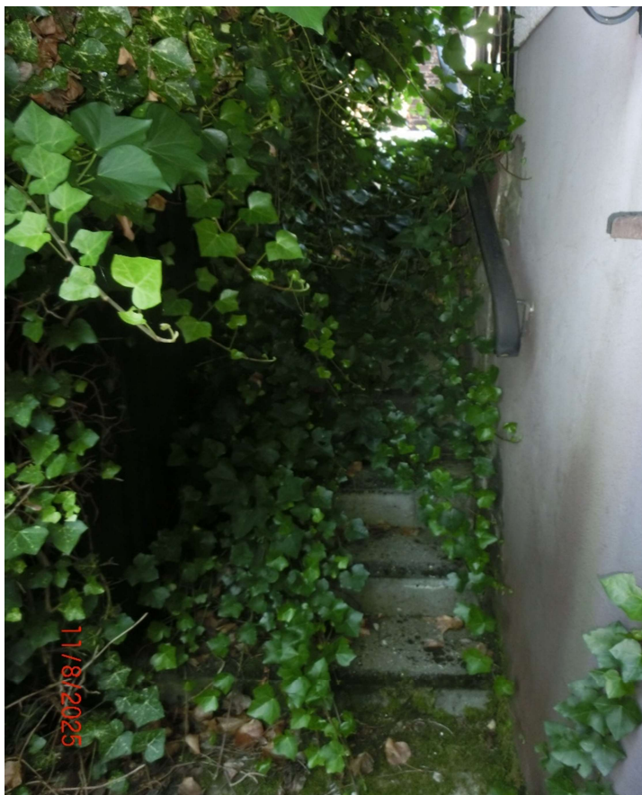
Terrassenüberdachung und Treppe zum Garten
