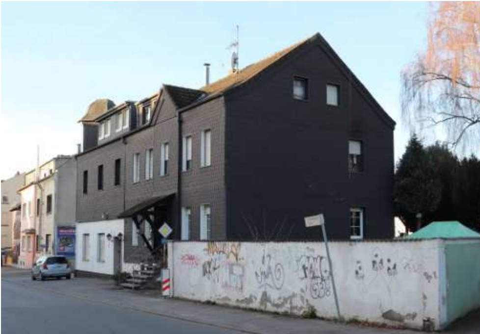
Bild 7 Seitenansicht Husener Straße 104
