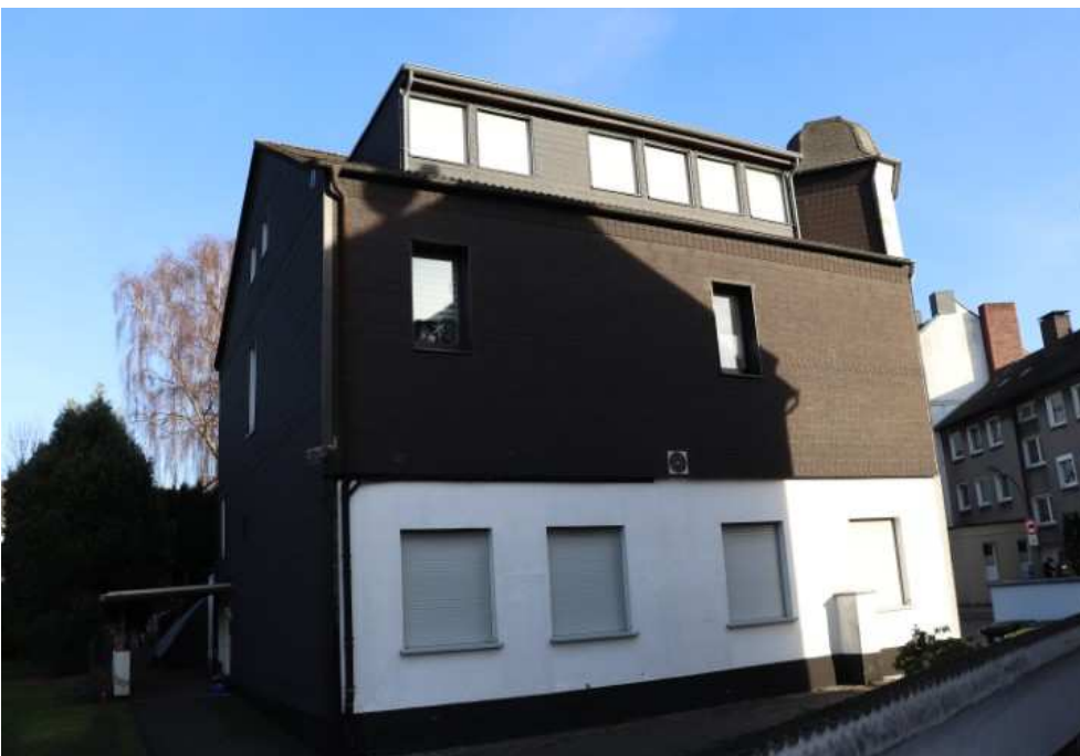
Bild 6 Seitenansicht Husener Straße 102
