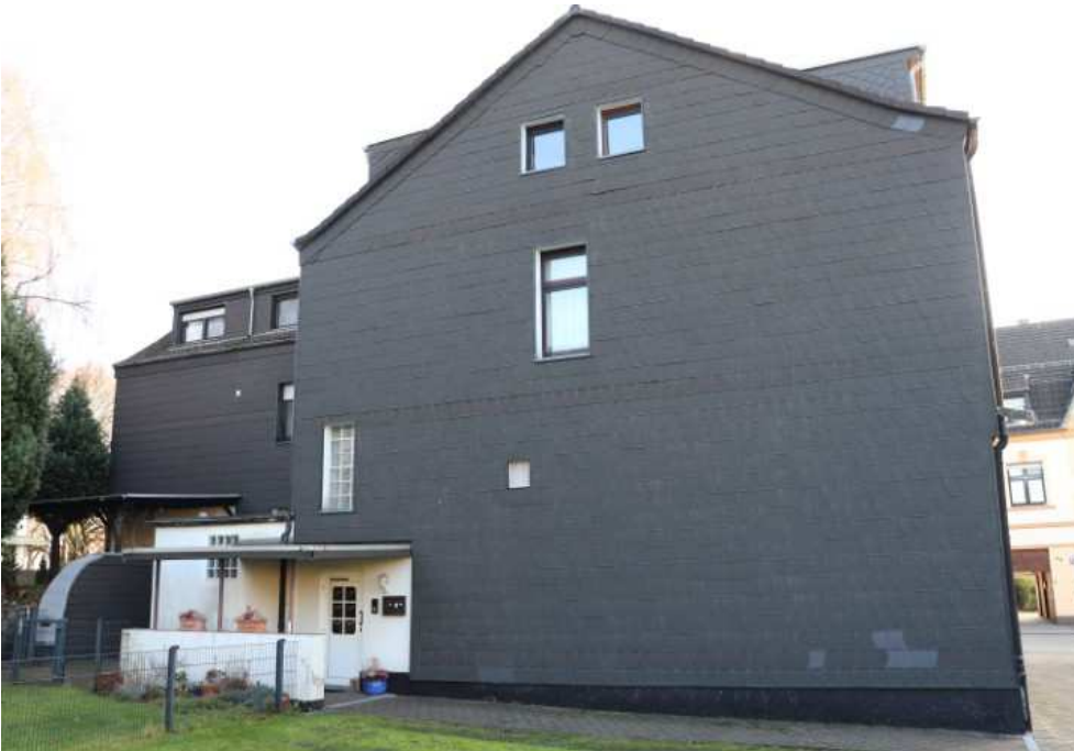
Bild 5 Rückseite Husener Straße 102, 104
