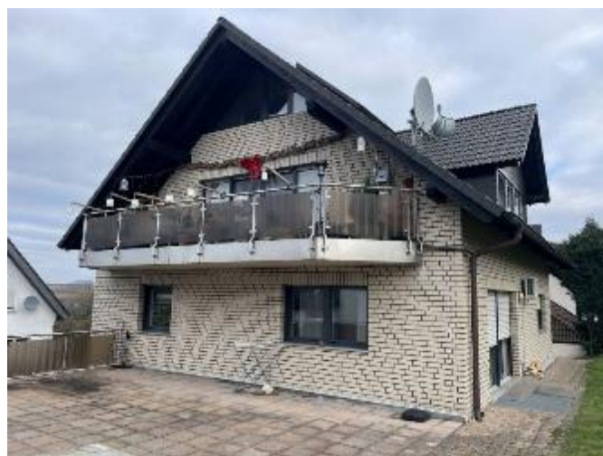
Südwestansicht mit Terrasse
