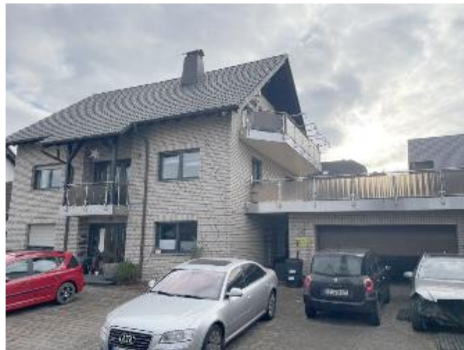
Dreifamilienhaus mit Garagenanbau Uhlandweg 13
