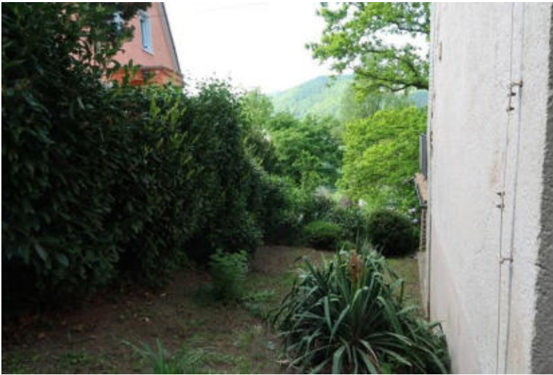
Blickrichtung Süden entlang der östlichen Giebelwand.
