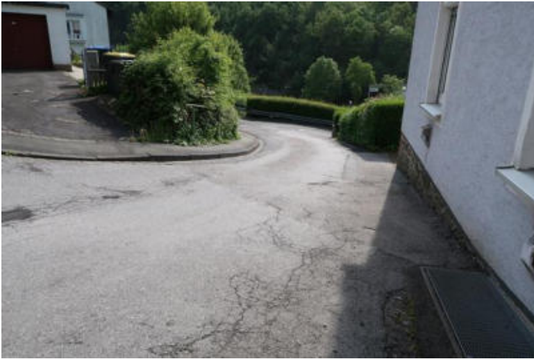
Nordstr. 28, öffentliche Straßenfläche im Bereich der Zufahrt zum Privatweg.
