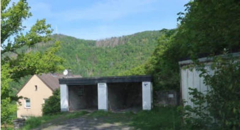
Doppelgarage des Nachbarn mit rd. 10 m 2 Überbau auf dem Grundstück des Bewertungsobjektes
