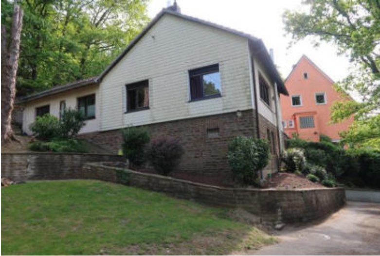
Wohnhaus Nordstr. 28, westliche Giebelseite und rückwärtig errichtetes Anbau.
