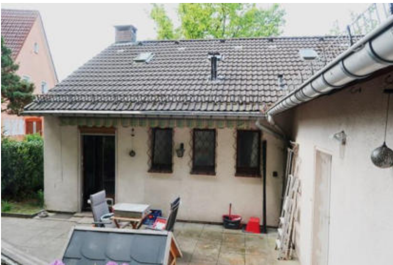
Blick auf das Ursprungsgebäude von Norden.
