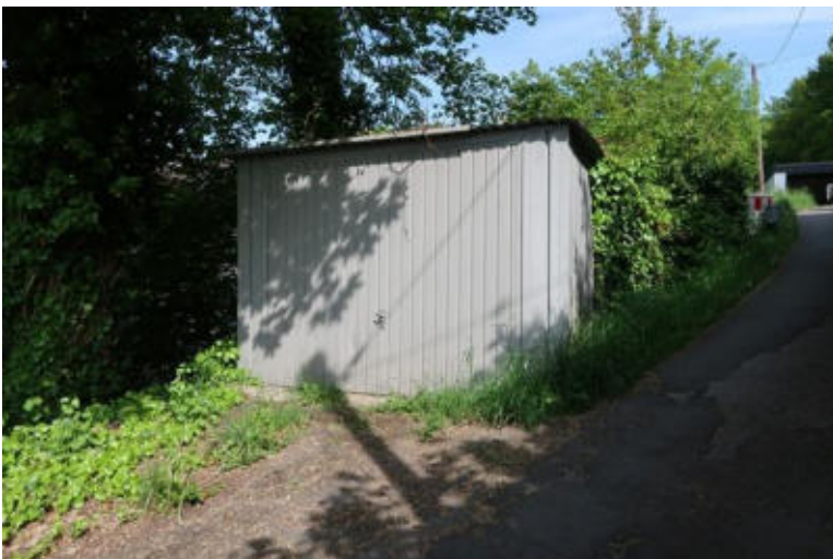
Blechgarage am Anfang des Privatweges, im rückwärtigen Bereich vollflächig mit Efeu bewachsen.
