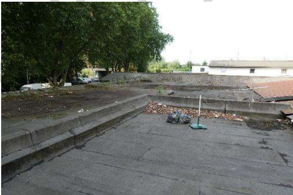
Bild 32 Bitumendach des straßenseitigen Bauteils
