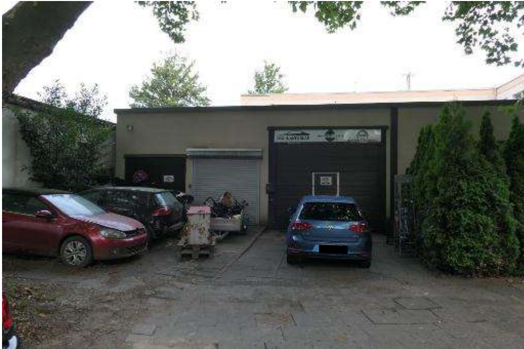
Bild 3 Blick auf Doppelgarage und Zufahrt zum Innenhof
