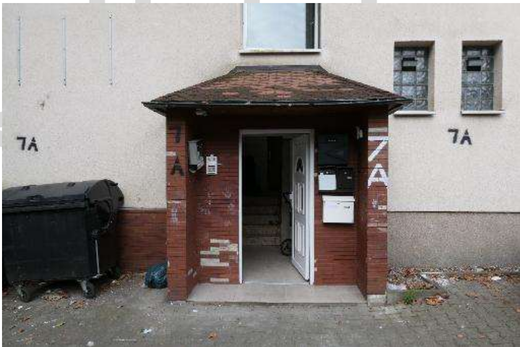
Bild 12 Hauseingang zum ersten Treppenhaus
