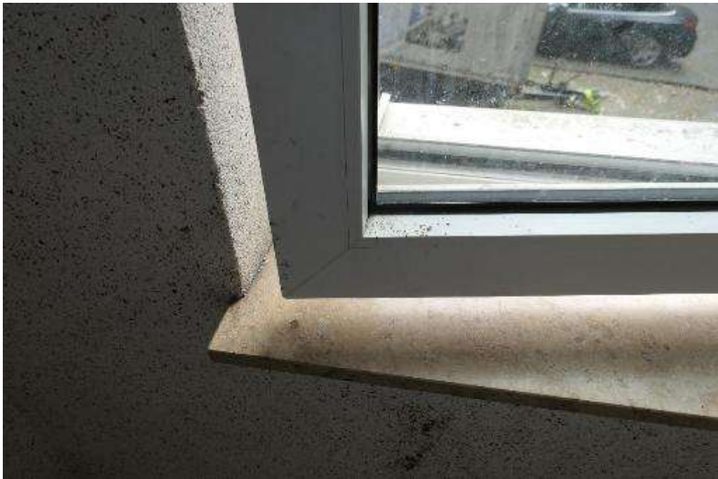
Bild 23 Kunststofffenster mit Isolierverglasung
