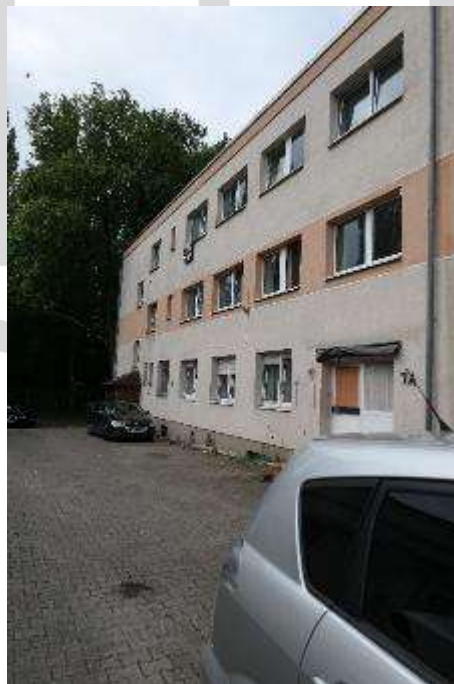
Bild 18 seitliche Ansicht der Fassade mit befestigter Grundstücksfläche
