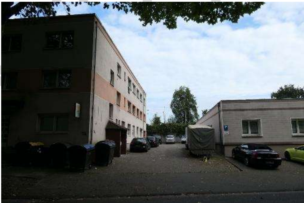
Bild 8 Zugang zu den Treppenhäusern
