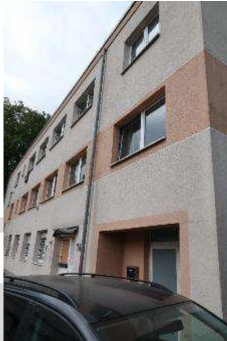
Bild 17 seitliche Ansicht der Fassade
