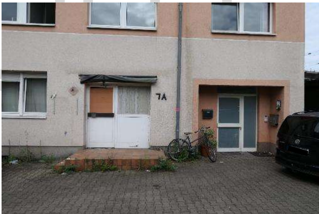
Bild 14 Haus Zugang zum zweiten Treppenhaus und Zugang zu einer Bürofläche
