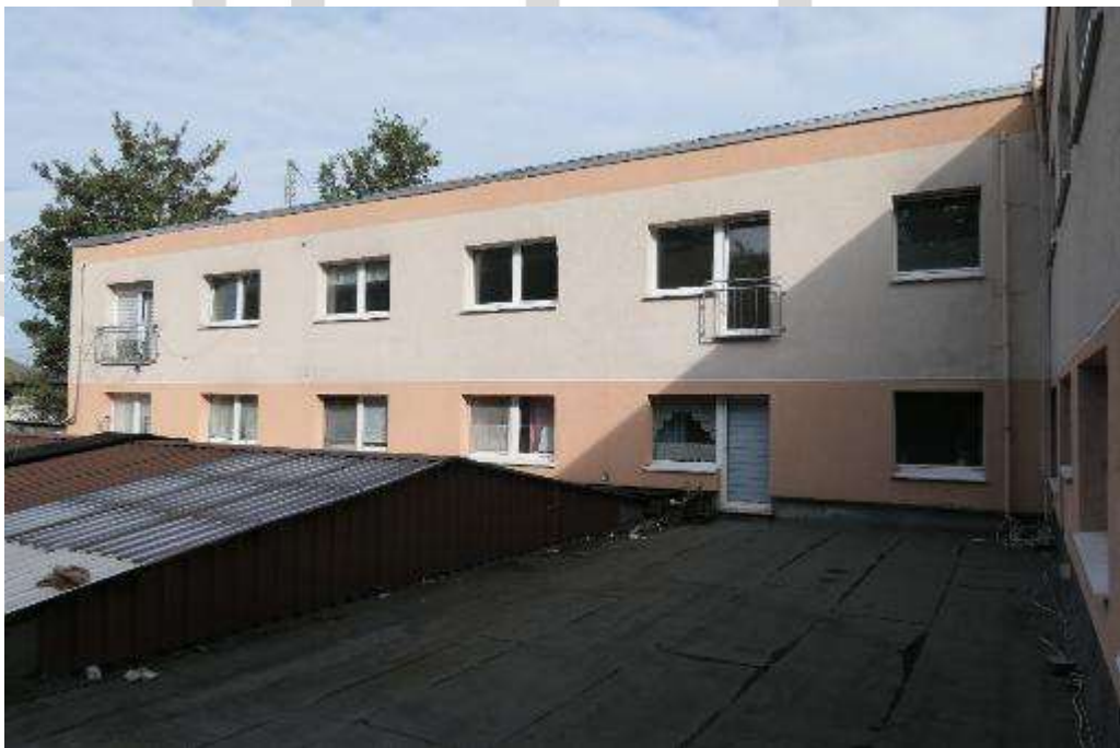
Bild 30 Blick auf den hinteren dreigeschossigen Gebäudeteil mit Wohnnutzung
