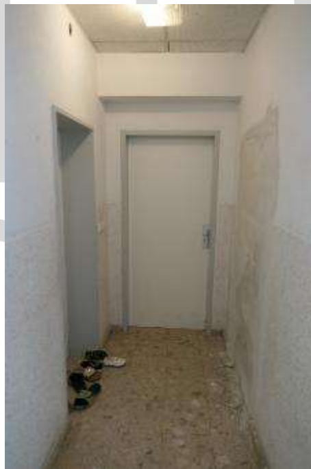
Bild 34 Flur im Treppenhaus
