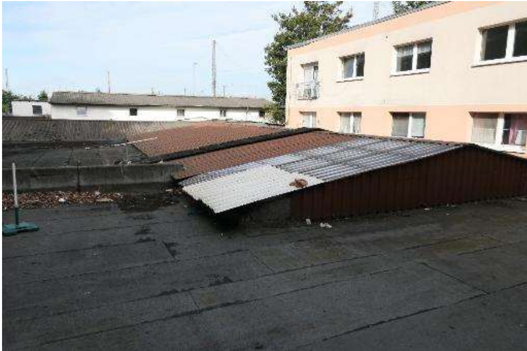
Bild 31 Überdachung des Hofes
