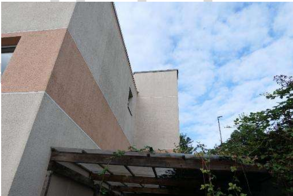
Bild 16 Ansicht des überbauten Aufzugschachtes
