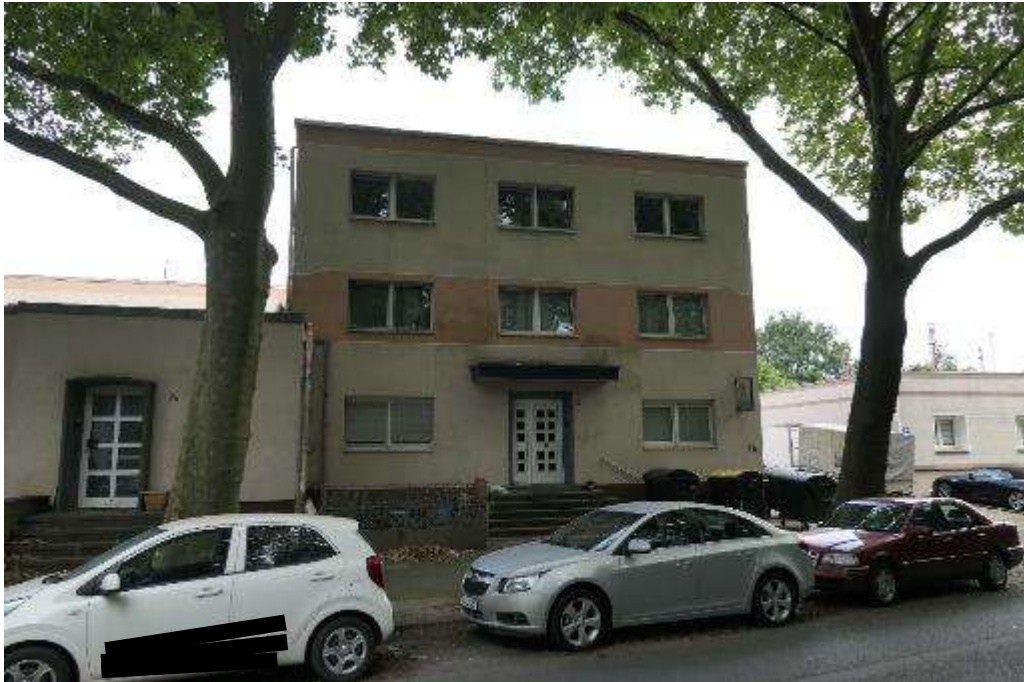
Bild 7 rechter Gebäudeteil mit Büro- und Wohnnutzung
