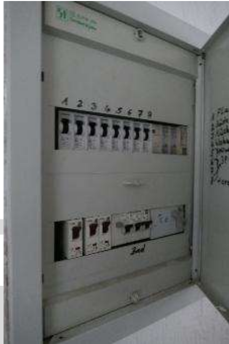
Bild 27 zeitgemäße Elektrounterverteilung
