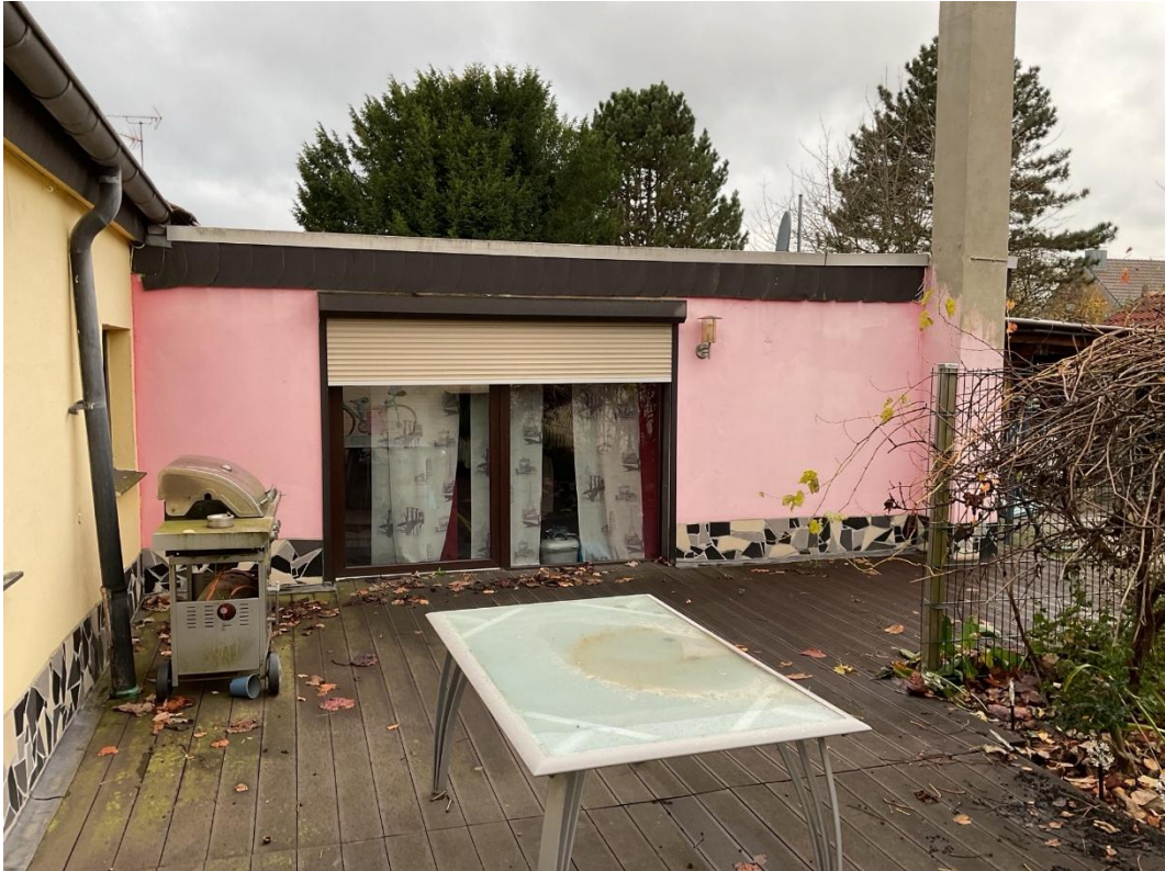
Bild 4: Terrasse und Seitansicht Anbau
