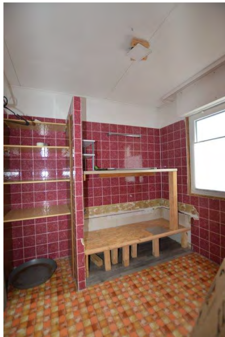
Erdgeschoss – ehemaliges Bad
