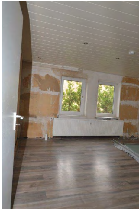
Unter-/ Kellergeschoss – Kinderzimmer
