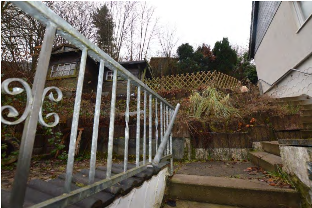
Treppen zum Hauseingang
