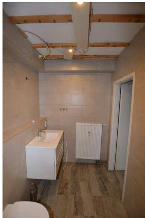
Unter-/ Kellergeschoss – Bad
