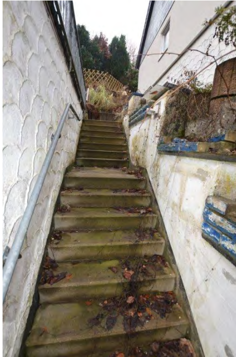
Treppen zum Hauseingang
