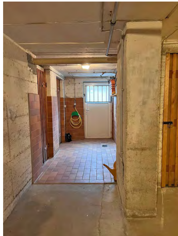
Ausgang zur Kelleraußentreppe
