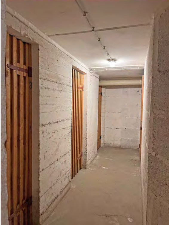
Kellerflur mit Abstellkellern hinten links
